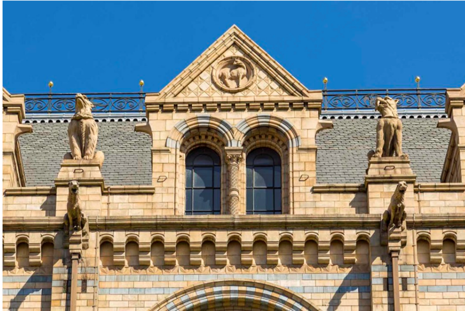
Şekil 8 : Tuğla ve Taş Malzemenin Yapıda Kullanımı
