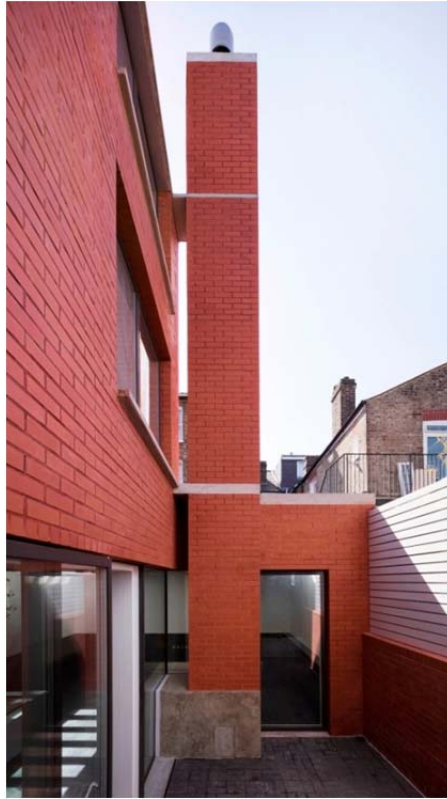
Şekil 7 : Tuğla Malzemenin Cephede Kullanımı (Red House/Londra)
