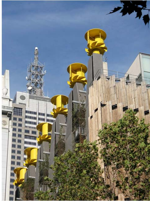
Şekil 68: CH2 (Avusturalya Belediye Meclisi Binası) Rüzgar Türbinleri
