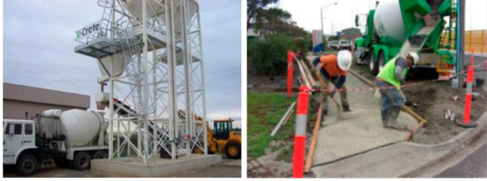
Şekil 2.2 E-Crete hazır beton tesisi ve uygulaması [6].
