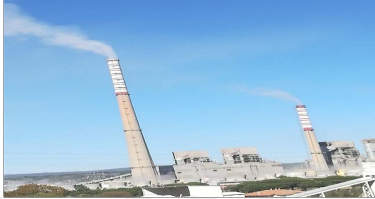
Şekil 3.4. Soma termik santrali
