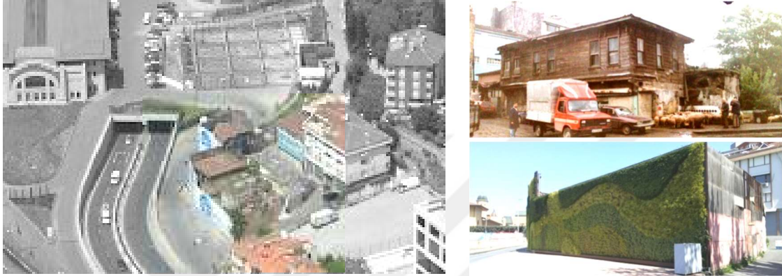
Şekil 5.3 Haliç Kongre merkezi ve Hamam hava fotoğrafı [374], Eski fotoğrafta camekan [375], Mevcut durumda hamamın etrafını çevreleyen yeşil duvar
