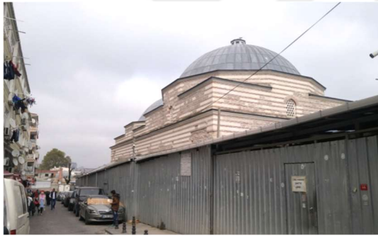
İtfaiye Caddesinden Hamamın giriş cephesi
