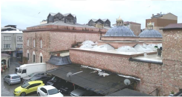
Süleymanpaşa sokağından Hamam ve otopark
