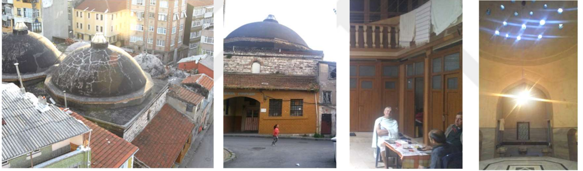
Hamamın üst örtüsü ve camekan girişi cephesi
