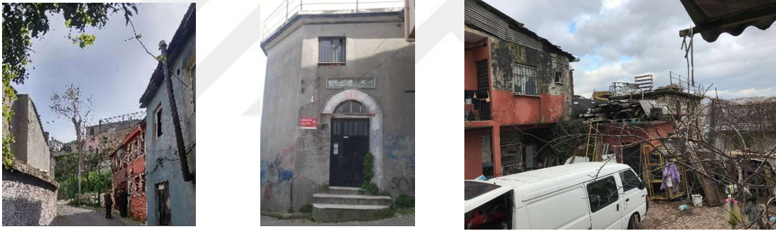
Hamamın oturduğu yamaç, giriş cephesi ve sıcaklık bölümü
