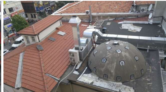
Hamamın üst örtüsü-sıcaklık kubbesi
