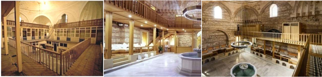
Şekil 5.14 Eski fotoğraflarda orta ölçekli bir külliye hamamı restorasyon sonrası özellikle kubbeli camekân bölümü soyunma odalarının azaltılması ve tuğla hatıllı taş duvarların ortaya çıkarılması ile ferah bir atmosfere sahip olmuştur [391]
