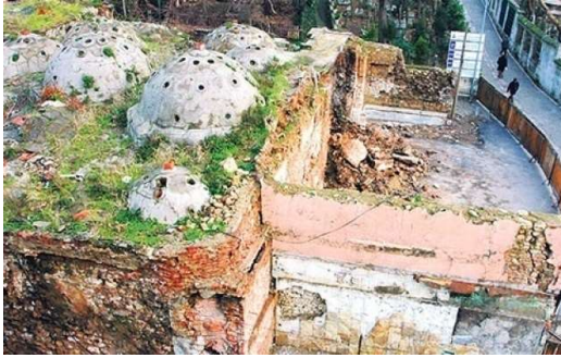
Restorasyon öncesi camekân ve sıcaklık
