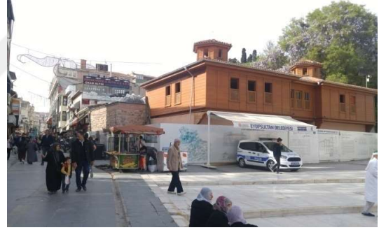
Mevcut durumda hamam restorasyonu
