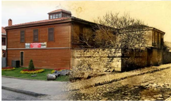
Hamamın camekan cephesi eski-yeni
