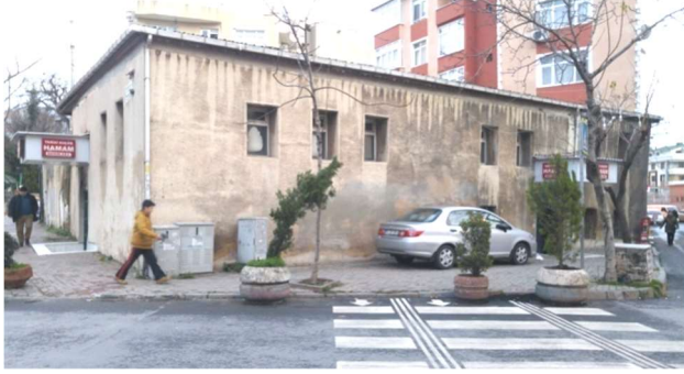
Altımermer Caddesinden Hamamın giriş cephesi
