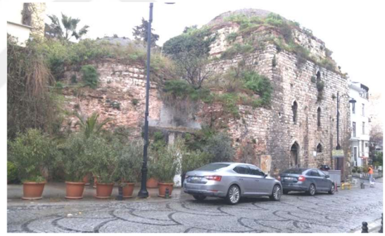
Akbiyık caddesinden hamam cephesi
