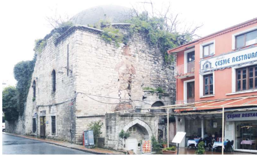
Erkekler kısmı giriş cephesi
