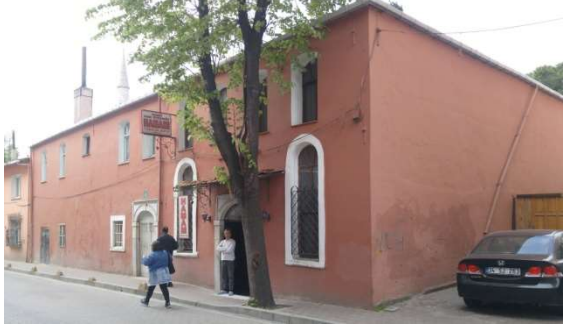
Hacı Evhad Cad. Hamamın giriş cephesi
