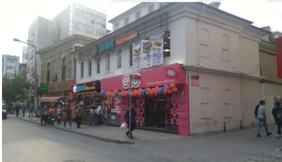
İstanbul Caddesinden Hamamın cephesi.
