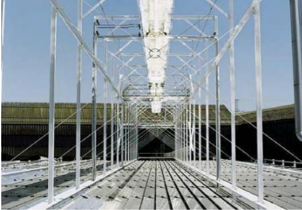
Şekil 2.22 : Fresnel tipi ısıl güneş enerji sistemi (European Solar Thermal Electricity Association, 2010).
