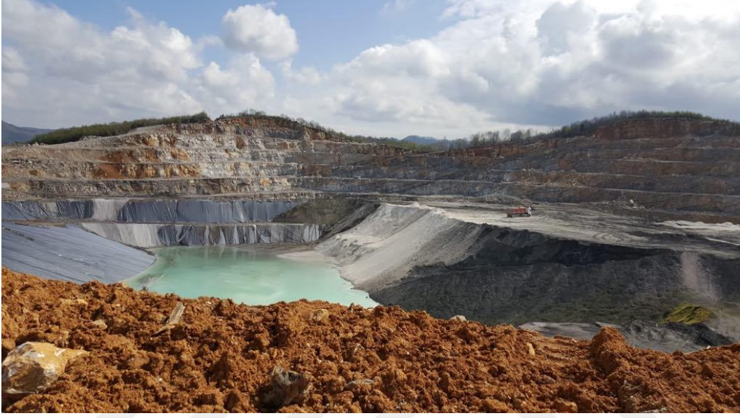
Şekil 4.5 Zonguldak Eren Enerji A.Ş taş ocağı kül barajı.
