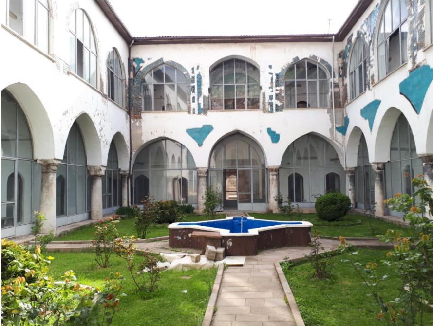
Resim 54: Tokat Gök Medrese iç avludan görünüm(giriş yönü) (fotoğraf: Aytaç GÜDER, 4.2018).
