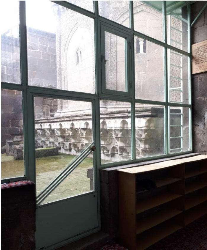
Resim 28: Kayseri Huand Hatun Türbesi'nin camii içinden görünümü (fotoğraf: Aytaç GÜDER, 3.2018).
