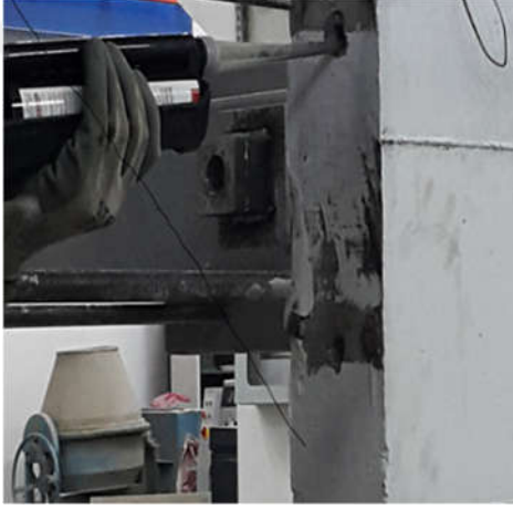
Epoksi Uygulamasıyla Ankraj Ekimi
