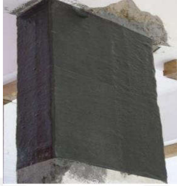
Şekil.1.6. Kolonun lifli polimer (LP) ile sarılması [7].
