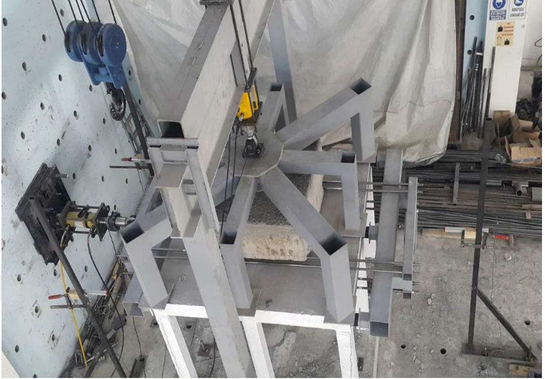
Şekil 2.77. Ölçüm cihazlarının montaj ve bağlantılarının yapılması.
