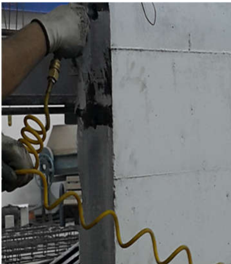
Açılan Deliklerin İçinde Bulunan Tozların Basınçlı Hava Yardımıyla Uzaklaştırılması.
