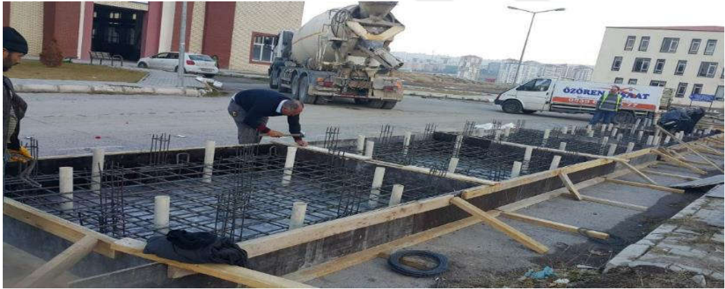
Şekil 2.23. Deney numune temelleri içine kancaların bağlanması.
