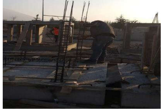
Şekil 2.26. Üst yapı için donatıların hazırlanması.
