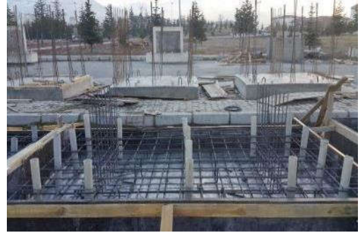
Şekil 2.22. Deney numunelerinin temelleri içine PVC boruların yerleştirilmesi.
