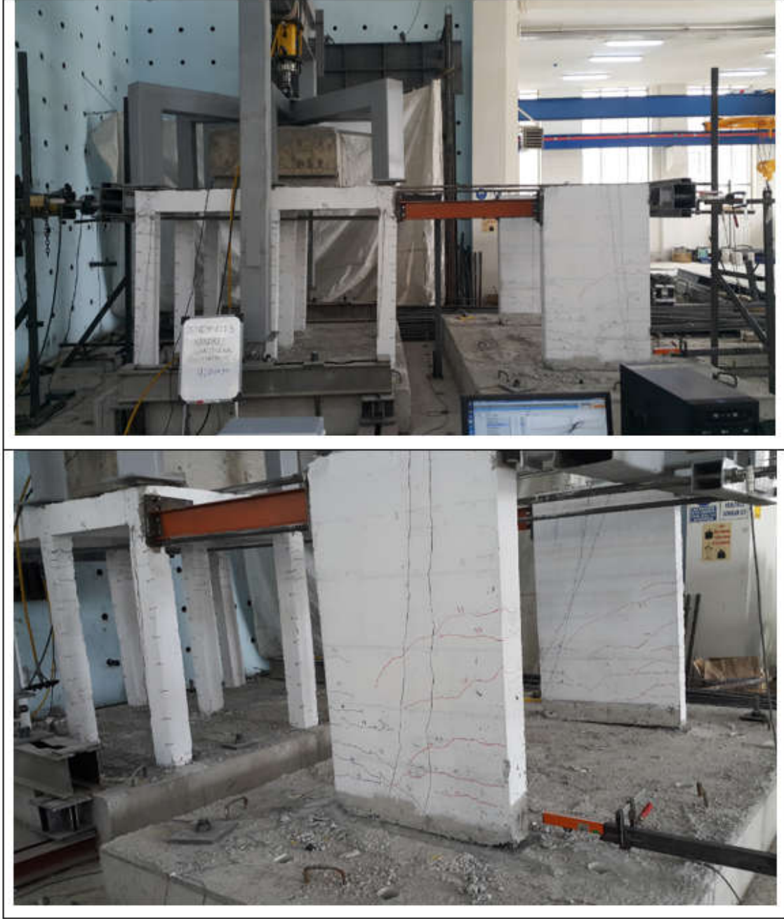
Şekil 3.53. 3.Deney sonunda çelik bağ kirişlerle bağlanan dış perdelerle güçlendirilmiş taşıyıcı sistemin görünümü.
