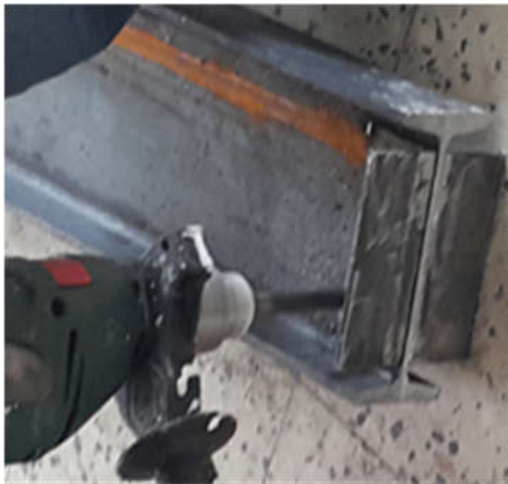
Çelik Bağ Kirişlere L Korniyerlerin Bulonlanması için Delik Açılması
