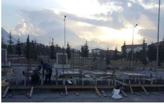
Şekil 2.22. Deney numunelerinin temelleri içine PVC boruların yerleştirilmesi.
