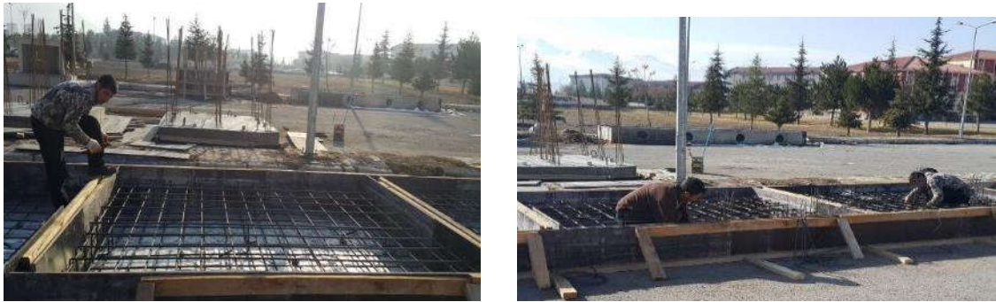
Şekil 2.21. Deney numunelerinin temel donatılarının yerleştirilmesi ve kolon-perde filizlerinin bağlanması.
