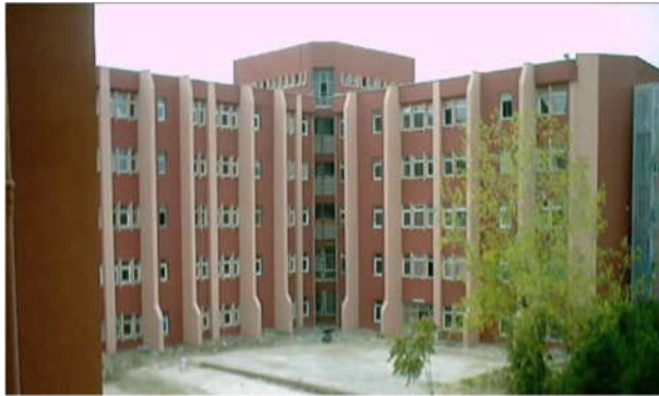
Şekil 1.10. İstanbul Üniversitesi'nde dış payandalar ile güçlendirilmiş bina uygulaması.
