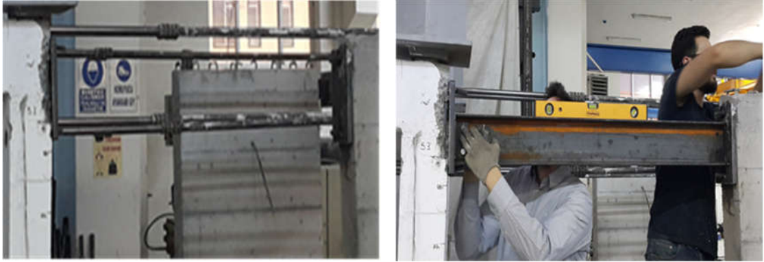
Çelik Bağ Kirişlerin Levhalar Arasına Yerleştirilmesi
