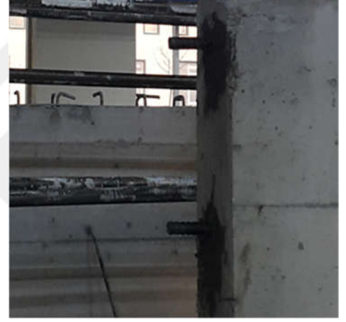
Epoksi Uygulamasıyla Ankraj Ekimi
