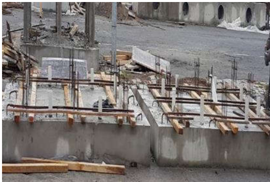
Şekil 2.26. Üst yapı için donatıların hazırlanması.
