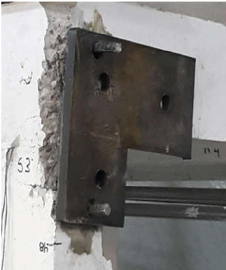
Kolona L şeklinde çelik levhanın kaynatılarak montajlanması
