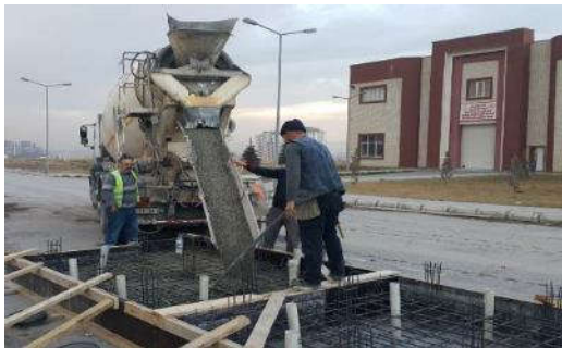
Şekil 2.24. Deney numune temellerinin betonlarının dökülmesi.
