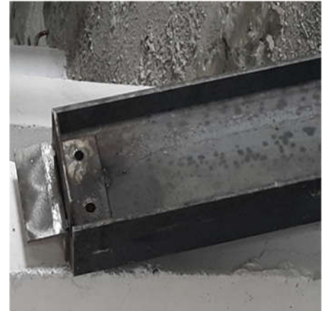
Çelik Bağ Kirişlere L Korniyerlerin Bulonlanması için Delik Açılması
