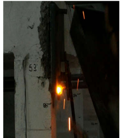
Kolona L şeklinde çelik levhanın kaynatılarak montajlanması
