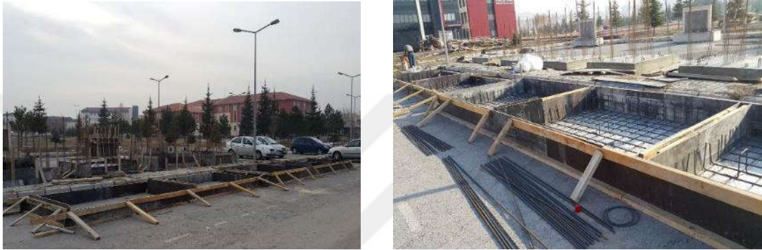
Şekil 2.20. Deney numunelerinin temelleri için kalıpların hazırlanması.
