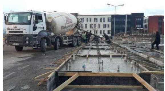
Şekil 2.24. Deney numune temellerinin betonlarının dökülmesi.
