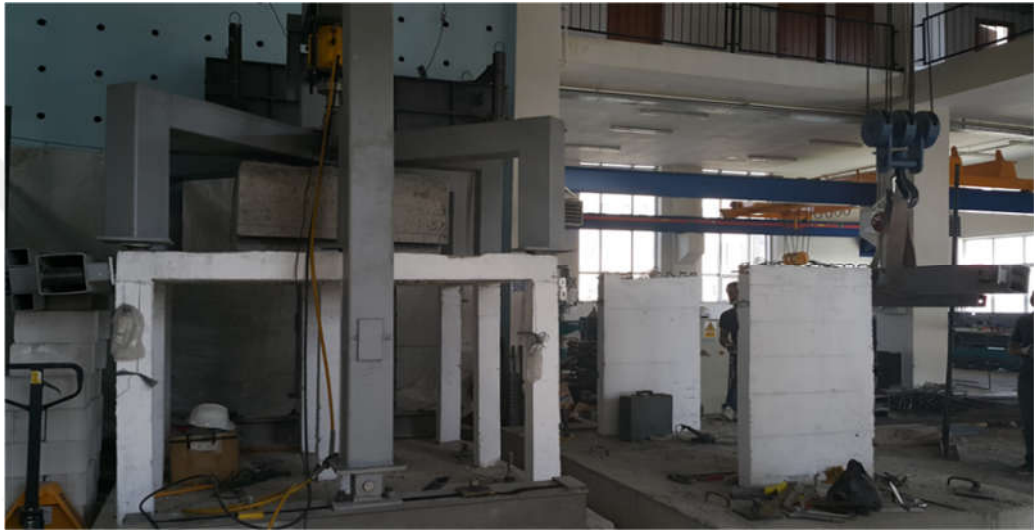
Şekil 2.82. Çerçevelerin güçlendirme perdeleriyle bağlandığı deneylerde yatay yükleme levhalarının montajı.
