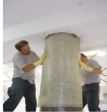
Şekil.1.6. Kolonun lifli polimer (LP) ile sarılması [7].
