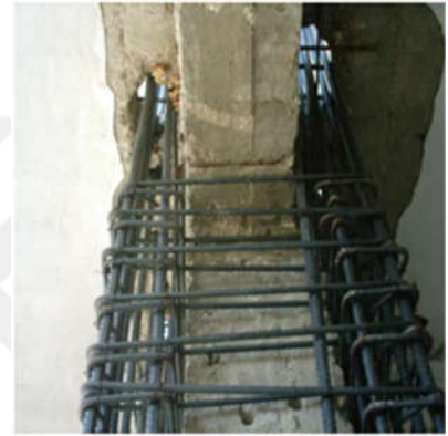
Şekil.1.5. Kolonun betonarme ile mantolanması uygulaması [3].
