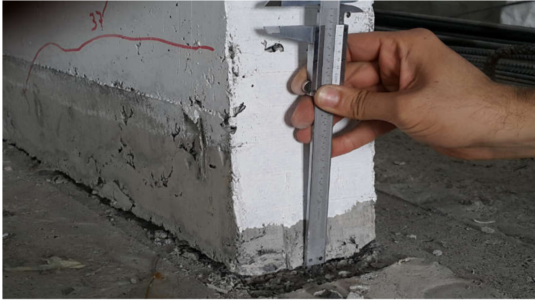
Şekil 3.51. 3.Deneyde güçlendirme için kullanılan 1 nolu dış perde tabanındaki ayrılma miktarının ölçülmesi.
