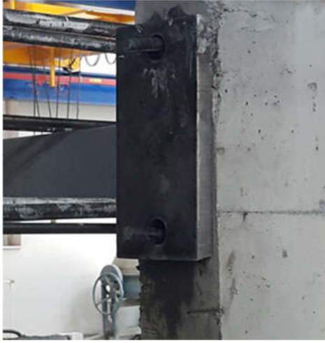
Perdeye dikdörtgen şeklinde çelik levhanın kaynatılarak montajlanması
