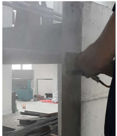
Açılan Deliklerin İçinde Bulunan Tozların Basınçlı Hava Yardımıyla Uzaklaştırılması.
