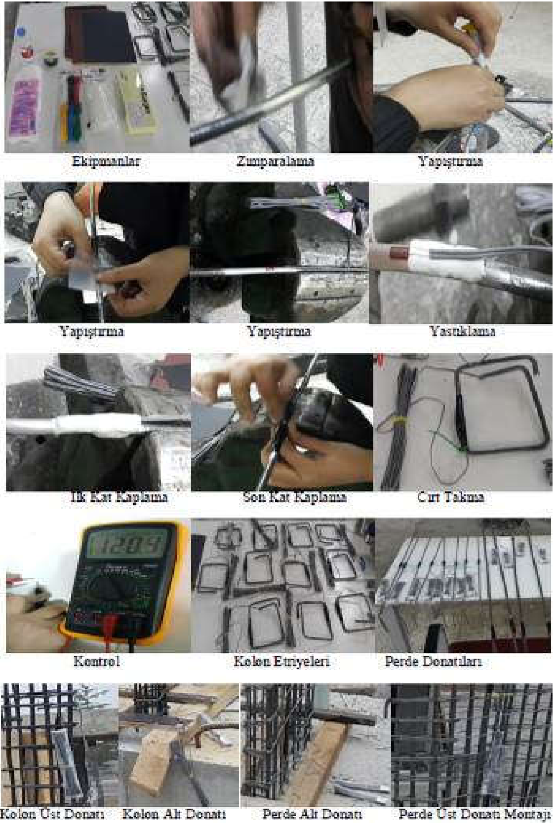
Şekil 2.27. Strain gaugelerin hazırlanışı ve montajı.
