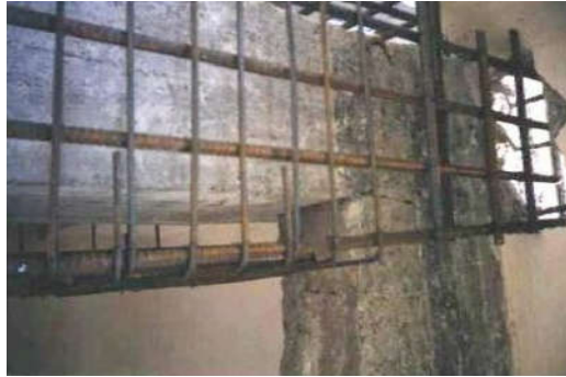
Şekil 1.4. Kiriş mantolanmasında donatılarda sürekliliğin sağlanması [6].
