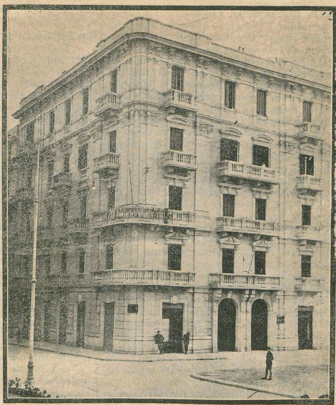
Il palazzo dove ha sede in Bari la Camera di Commercio “ Italo-Orientale ”
