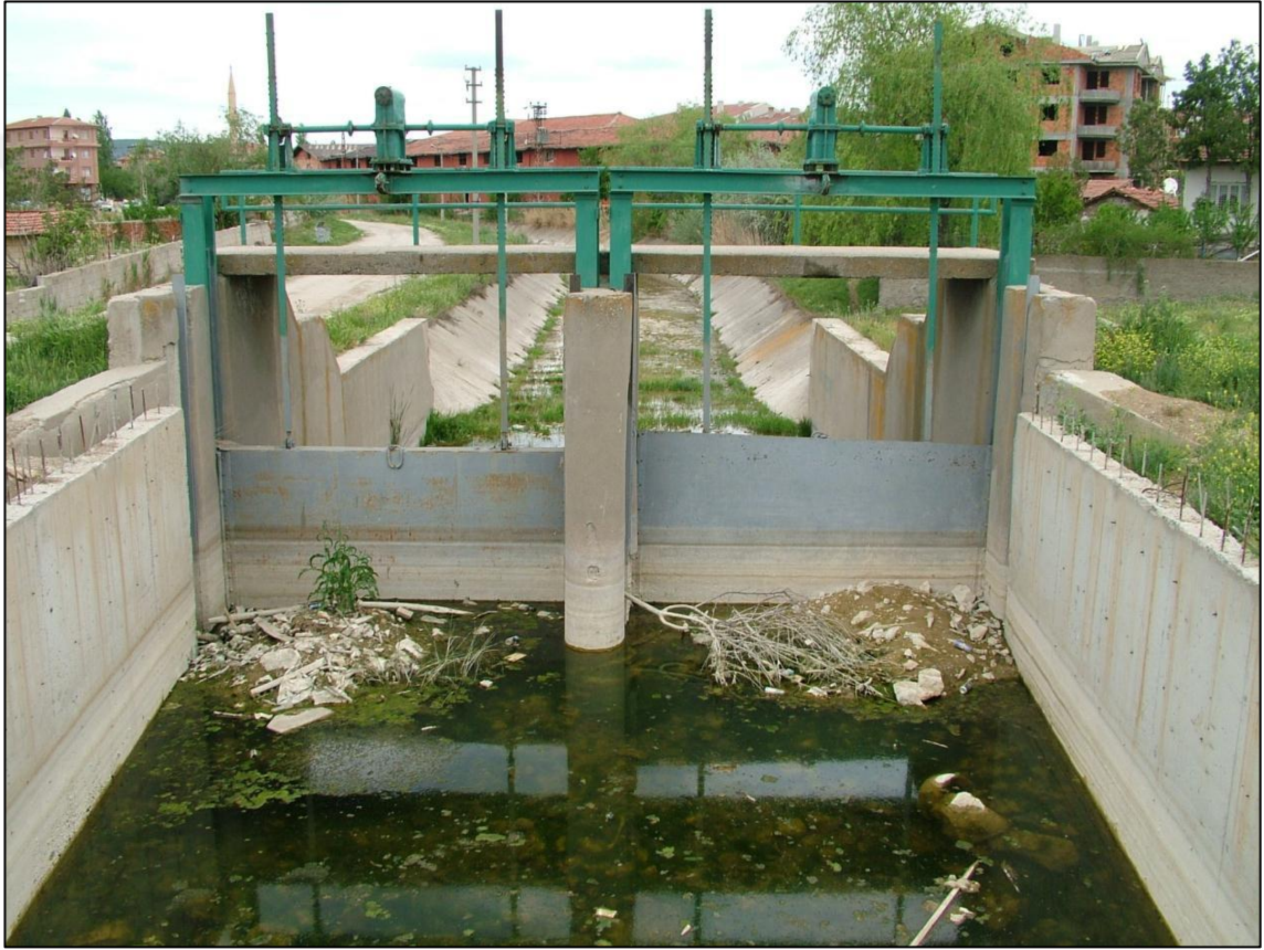
Şekil 5.1 Mogan Gölü kuzeyinde bulunan su kontrol yapısı (DSİ 2008)
