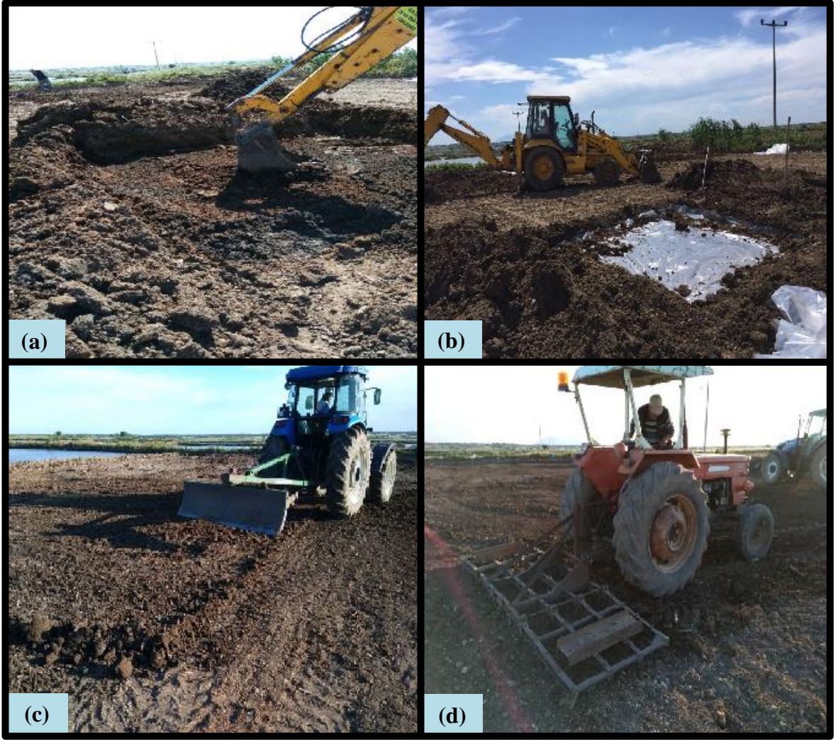
Şekil 3.8. Su tutma bariyerlerinin yerleştirilmesi (a), su tutuma bariyerinin kapatılması işlemi (b), kaba tesviye (c), tırmık uygulaması (d)
