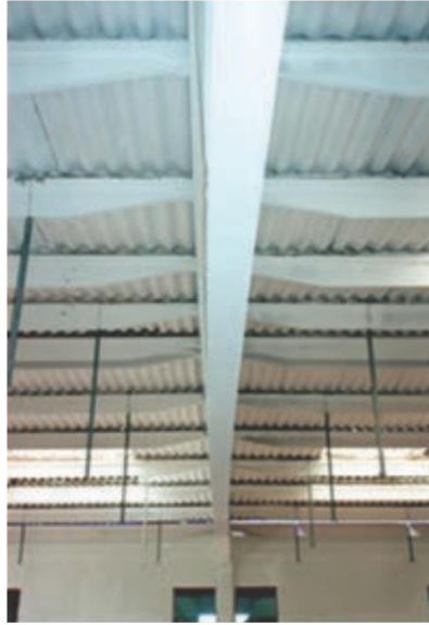
Şekil 1.1. Depremden sonra Üst başlık yaklaşık 30 cm deplasman yapmış(Barka, A.G., Kulaksızoğlu, A. (2013))
