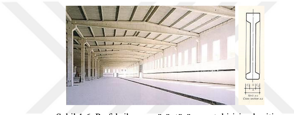
Şekil 1.6. Prefabrik yapı görüntüsü ve çatı kirişi enkesiti
