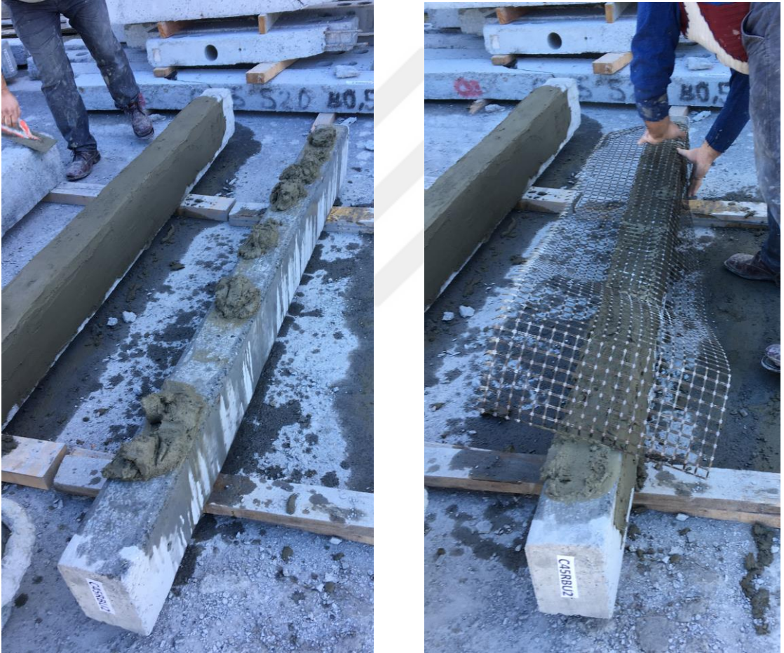
Şekil 2.3 Kirişe tamir harcı uygulama aşamaları
