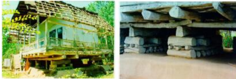
Şekil 1.5. Yuvarlak kütüklerle deprem izolasyonu (Naderzadeh, 2009).
