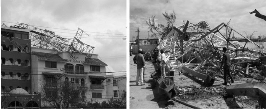
Şekil 1.1. Rüzgar etkisiyle çöken telekomünikasyon yapısı (Hugo Herná'ndez Barrios vd., 2013)
