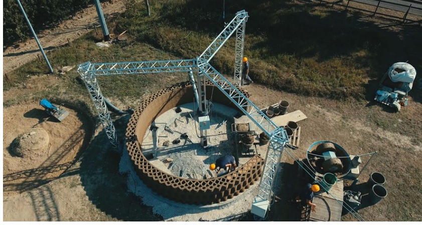
Şekil 3.19 Gaia evinin duvarlarının üç boyutlu yazıcıyla basımı [92]
