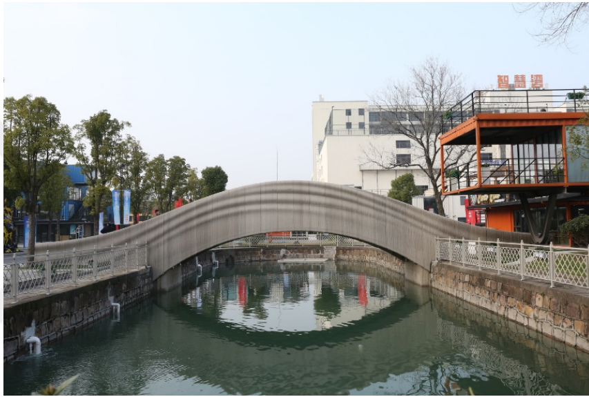
Şekil 3.29 Dünyanın üç boyutlu basılan en uzun beton köprüsü [99]
