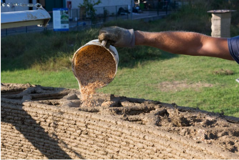
Şekil 3.20 Basılan duvarların içleri yalıtım amaçlı pirinç kabuklarıyla doldurulması [92]
