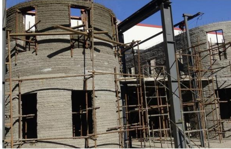
Şekil 3.39 Two - Story Villası üç boyutlu basılması [110]
