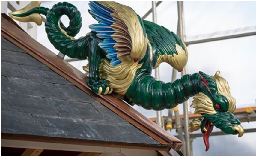
Şekil 3.54 The Great Pagoda ejderhaların parçalarının basımı sonrası montesi [115]
