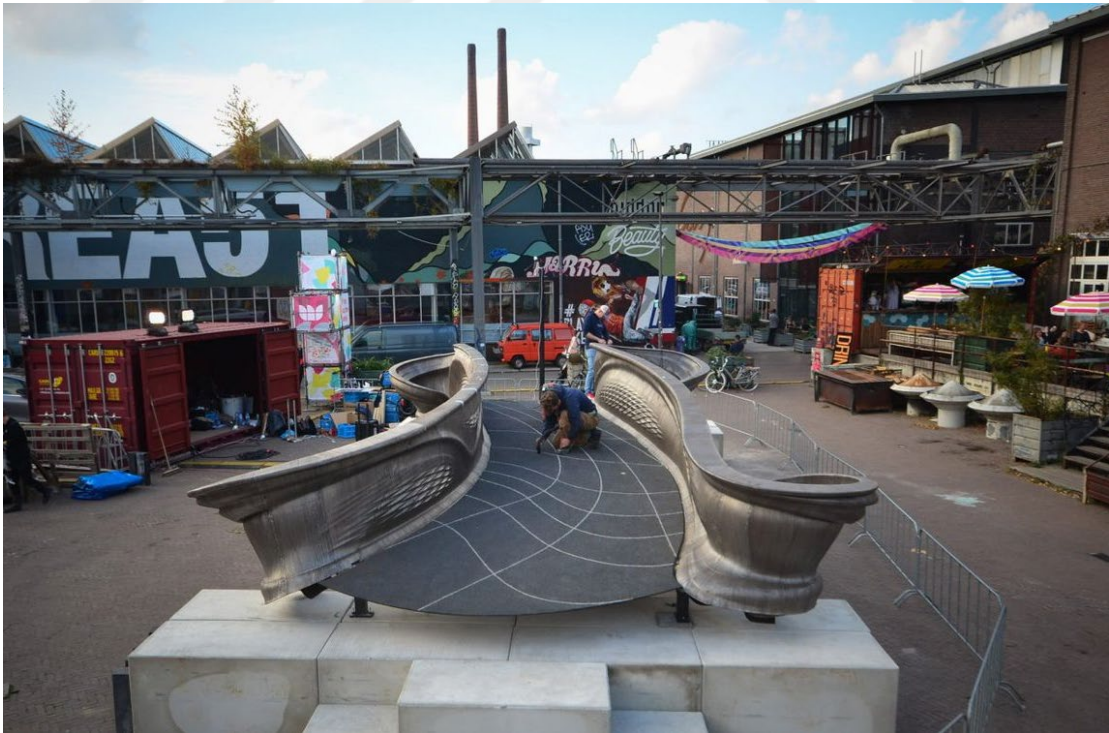
Şekil 3.28 Üç boyutlu basılan metal köprü [96]
