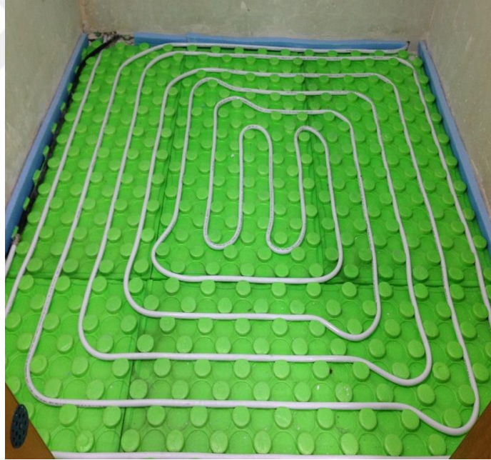
Şekil 3.17 Test odasının şap altı görünümü
