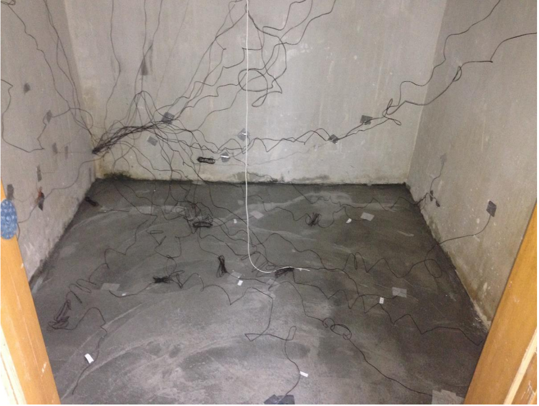
Şekil 3.19 Test odasına ısı çifti yerleştirilmiş görünümü
