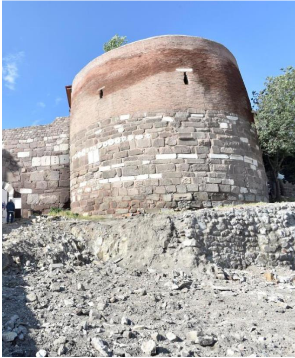
Resim 2.3. Ankara Kalesi 15 numaralı burç 2016 yılı onarım çalışmaları (AV Arşivi)
