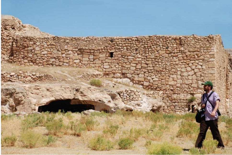
Resim 2.19. Hasankeyf Kalesi hatıl kullanılmamış moloz taş duvar (2008)
