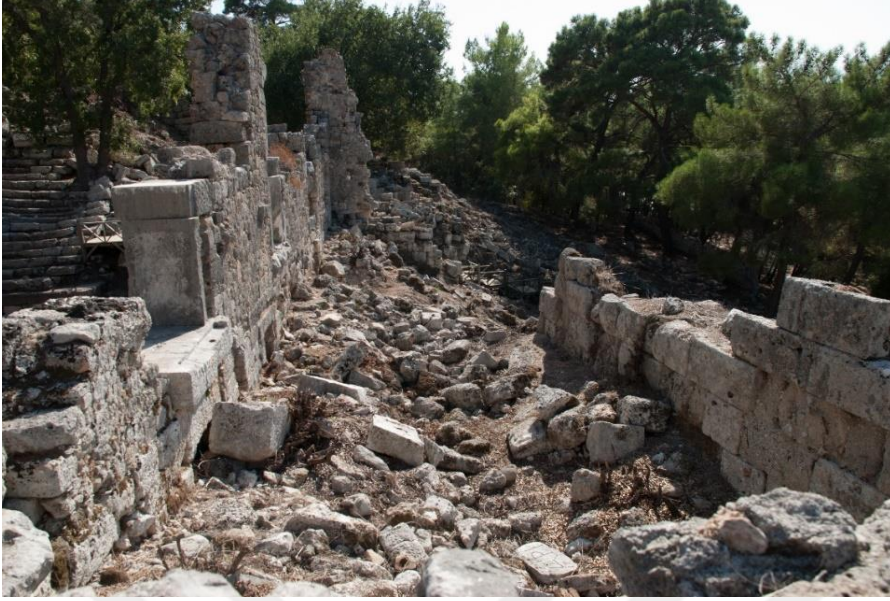
Resim 2.9. Phaselis Antik Tiyatrosu sahne bölümü yıkılan duvarlar (2014)
