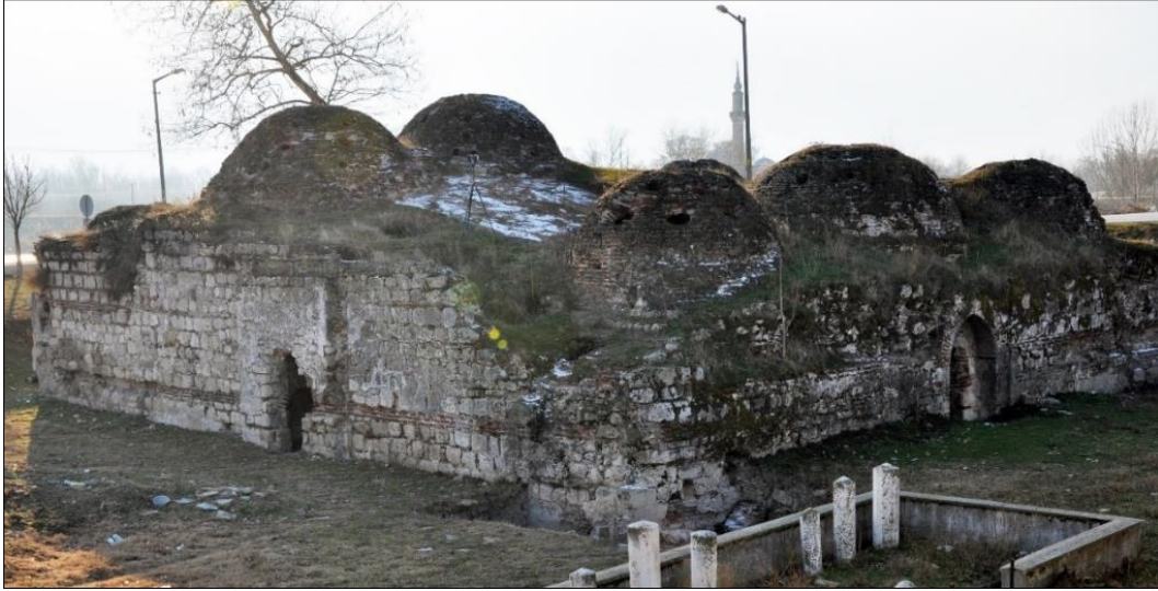
Resim 3.3. Mihâl Bey hamamı kuzeydoğu köşesi görünüş
