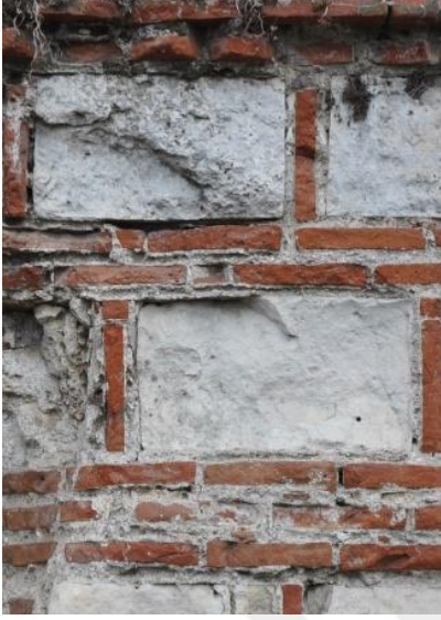
Resim 3.2. Mihâl Bey Hamamı almalı beden duvar örgüsü
