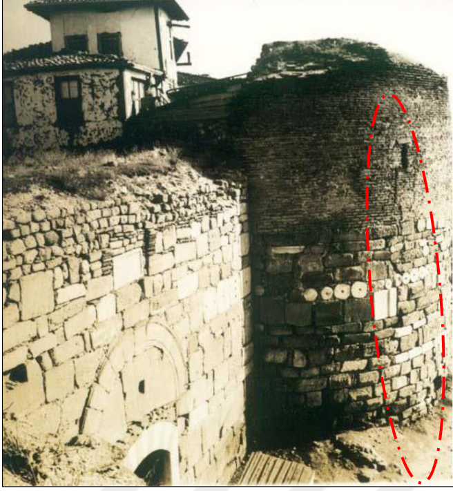
Resim 2.2. Ankara Kalesi 1935-1940 yılları arası çatlakları (AV Arşivi)
