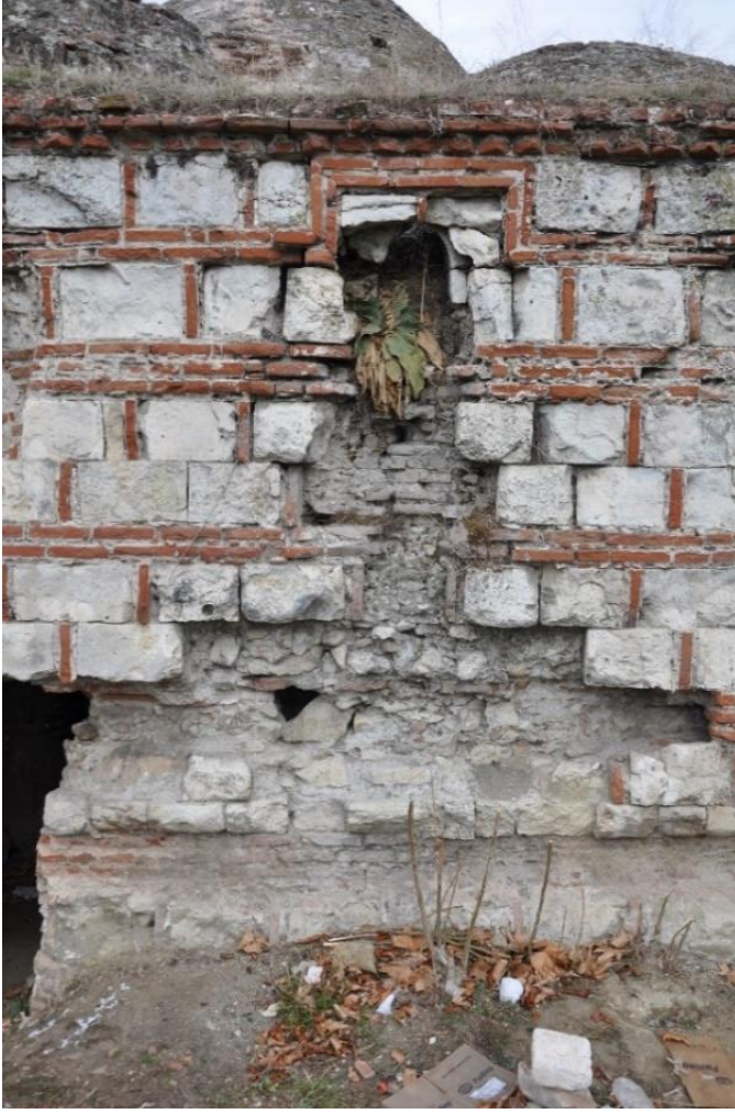
Resim 2.13. Mihâl Bey Hamamı güney cephesi taş erimleri (2016)
