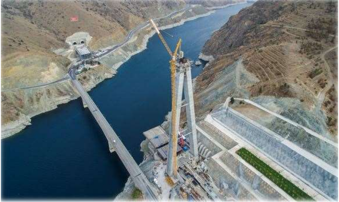
Şekil 18. Yeni Kömürhan Köprüsü inşaat çalışmaları (2019).
