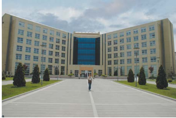
Şekil 3.19 : İstanbul Kültür Üniversitesi dış cephe görseli.
