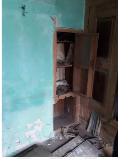
Resim3.7.97 Zemin Kat Oda
