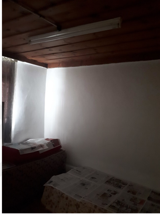
Resim 3.13.144 Zemin Kat Oda
