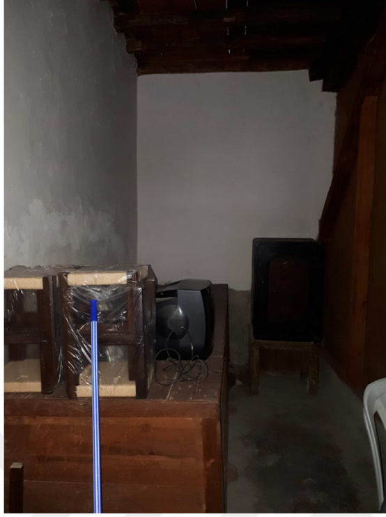
Resim 3.1.11 Zemin Kat Tuvalet Holü
