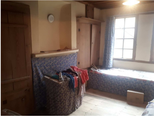
Resim3.13.145 Zemin Kat Oda
