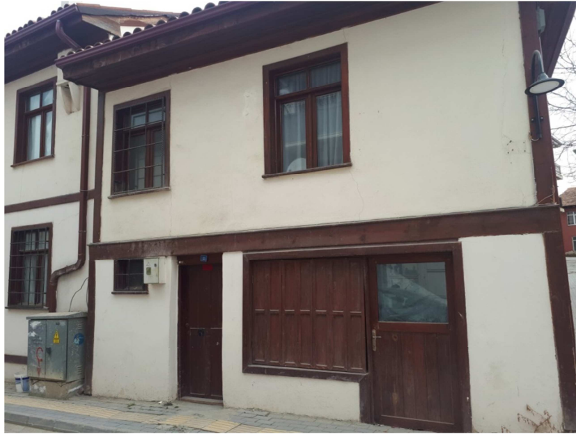
Resim 3.15.167 Kuzey Cephe Görünümü
