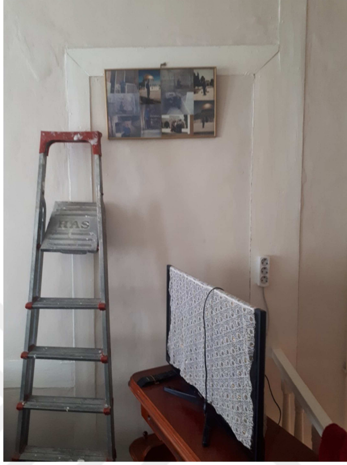
Resim 3.3.76 1.Kat İptal Edilen Oda Kapısı
