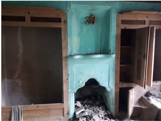
Resim3.7.95 Zemin Kat Oda
