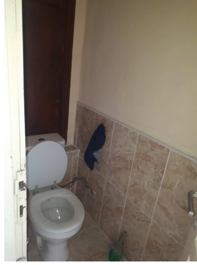
Resim 3.3.70 Zemin Kat Tuvalet
