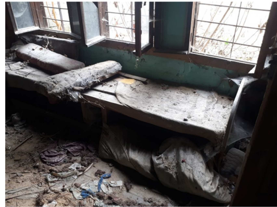
Resim3.7.96 Zemin Kat Oda
