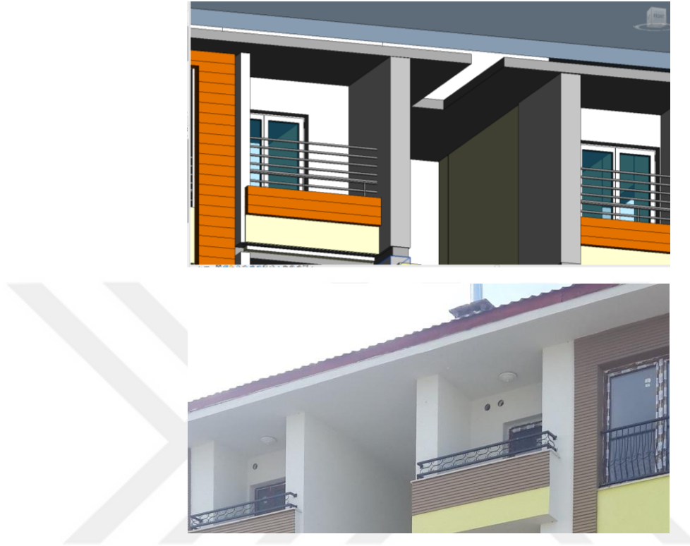
Şekil 5.3. YBM Modeli ile gerçek durumda kıyaslanması
