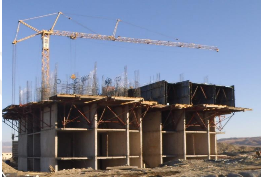
Şekil 3.4. Toplu konut tünel kalıp uygulaması.
