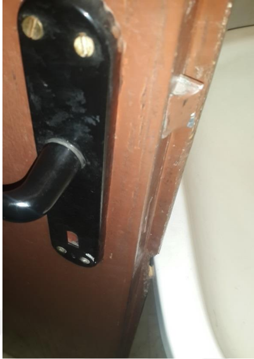
Şekil 3.6. Lavabo ve kapı çakışmasına özel bir konuttan örnek.
