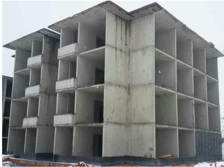
Şekil 4.30. Tünel kalıp sistem imalat görünümü (TOKİ)
