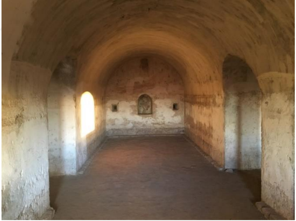
Şekil 3.47: K9 Koğuşu doğu duvarı.
