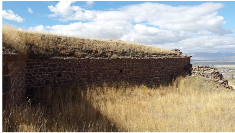
Şekil 6.1: Doğu Cephesi Harpuştaları.
