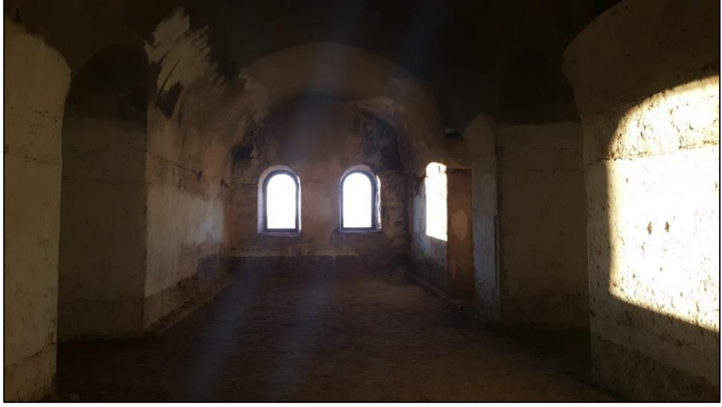
Şekil 3.40: K6 Koğuşu batı duvarı.
