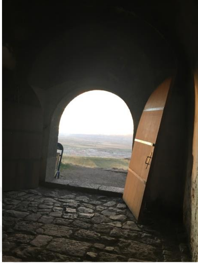
Şekil 3.87: Özgün olmayan tabya giriş kapısı-Y201.
