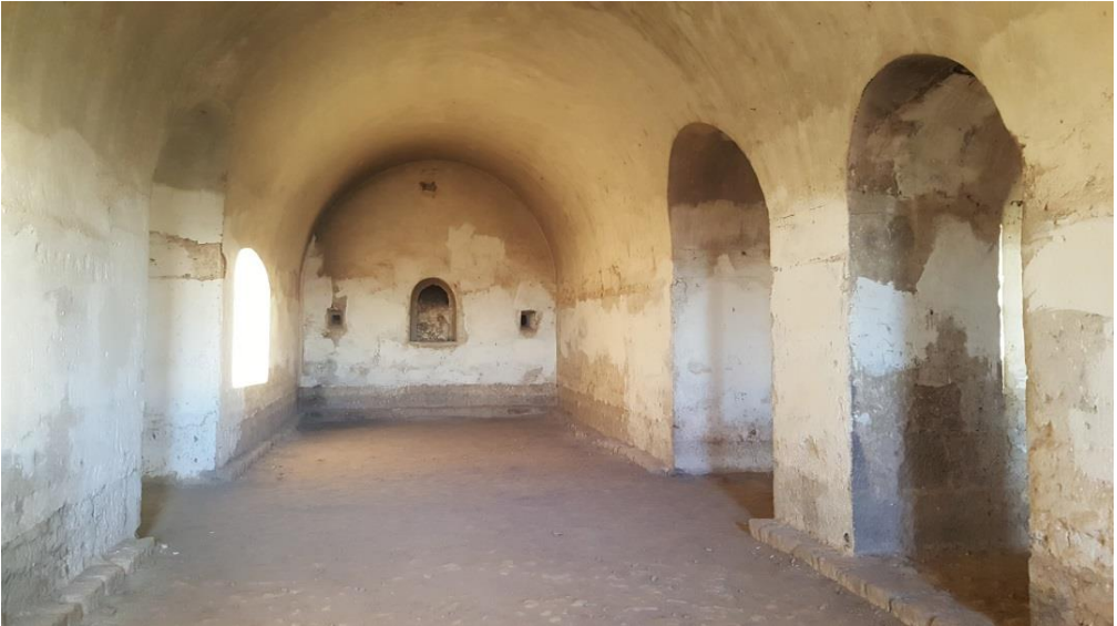
Şekil 3.43: K7 Kođuşu dođu duvarı.
