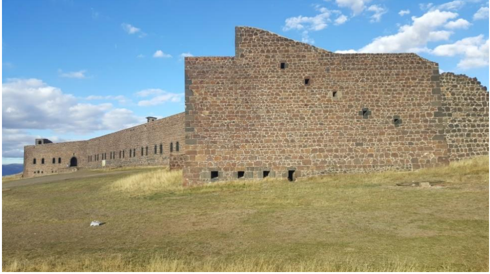
Şekil 3.81: Mecidiye Tabyası güney cephesi.
