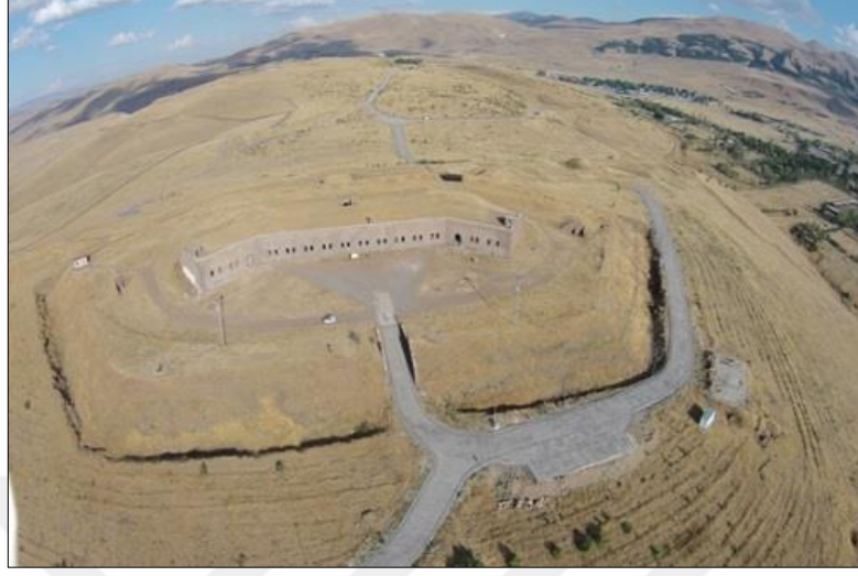
Şekil 3.14: Mecidiye Tabyası çatısı ve toprak örtü.
