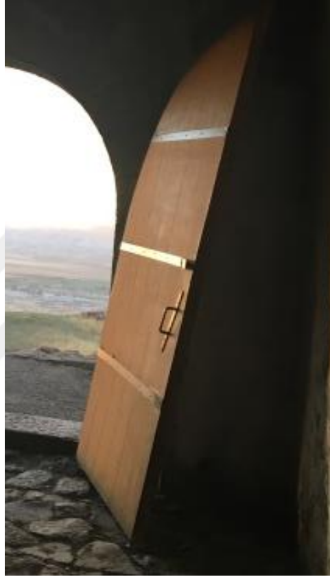
Şekil 3.93: Özgün olmayan tabya giriş kapısı-Y201.
