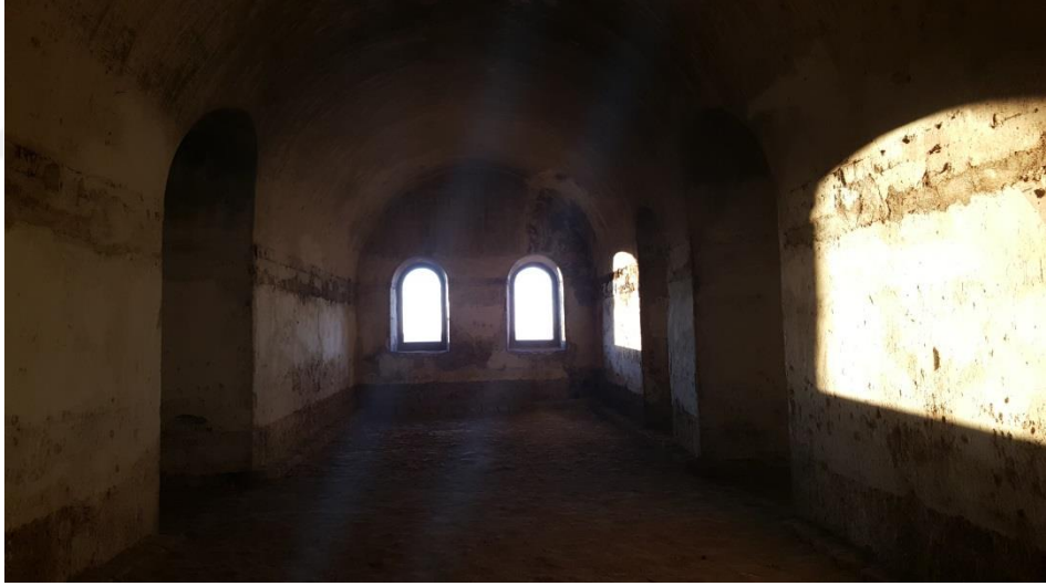
Şekil 3.44: K8 Koğuşu batı duvarı.
