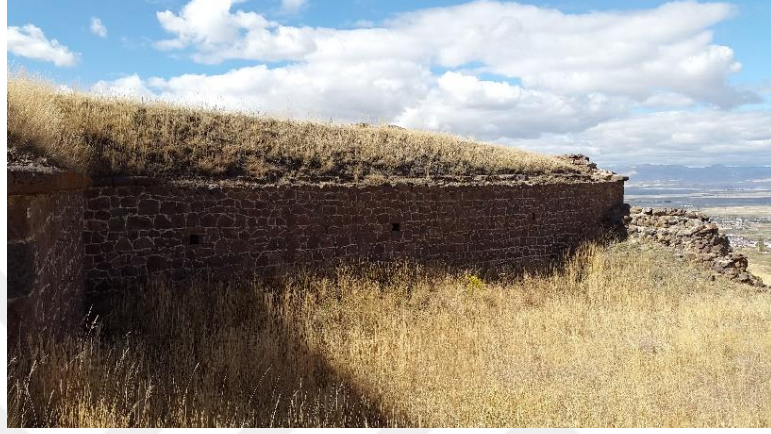
Şekil 3.84: Mecidiye Tabyası çatı ve doğu cephesi toprak dolgu.
