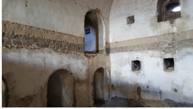
Şekil 6.2: Tuvalet ve Hamam döşeme izleri.
