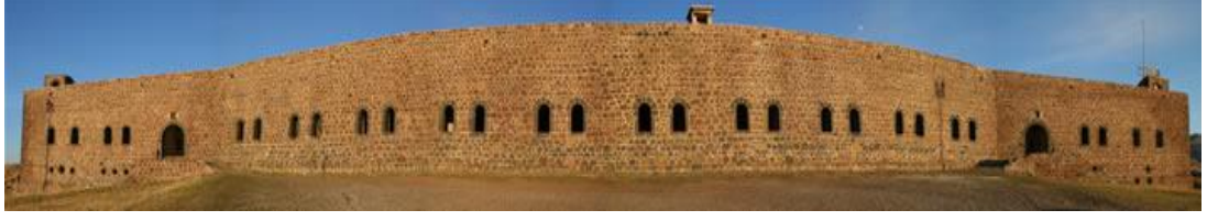
Şekil 3.79: Mecidiye Tabyası batı cephesi.
