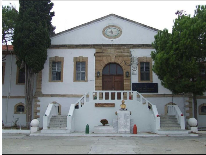
Şekil 2.23: Kışla Binası-Değirmenburnu Tabyası-Çanakkale.
