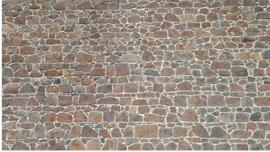
Şekil 3.82: Mecidiye Tabyası kuzey cephesi beden duvarı.
