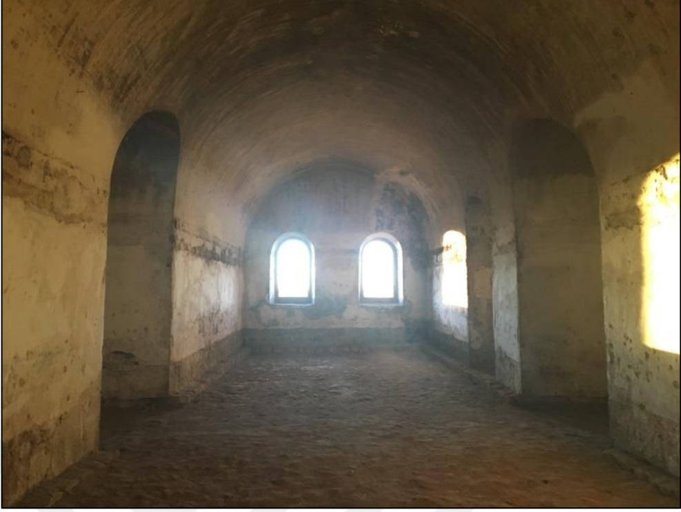
Şekil 3.46: K9 Koğuşu batı duvarı.
