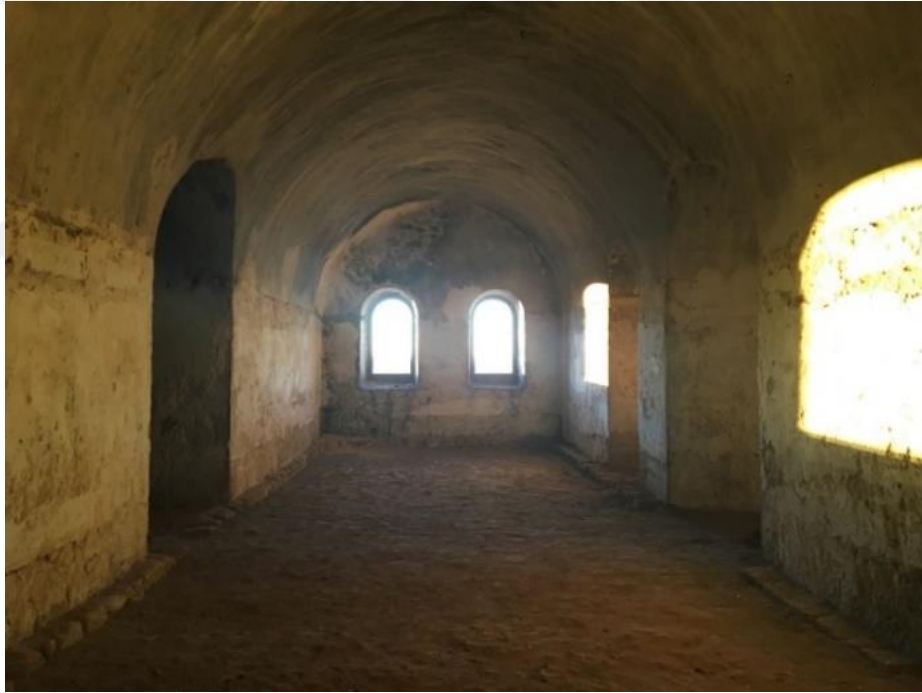
Şekil 3.48: K10 Koğuşu batı duvarı.
