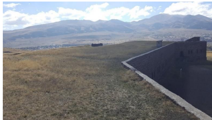
Şekil 3.88: Mecidiye Tabyası çatısı toprak örtüsü
