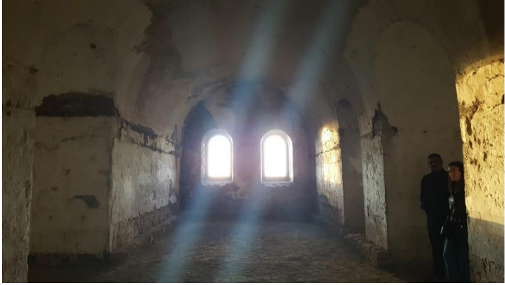
Şekil 3.33: K2 Koğuşu batı duvarı.
