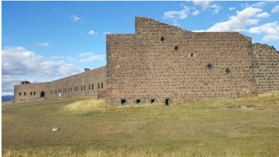
Şekil 4.2: Mecidiye Tabyası Güney Cephesinin Günümüzdeki Durumu.
