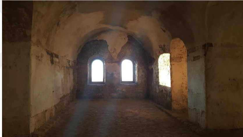
Şekil 3.36: K4 Koğuşu batı duvarı.
