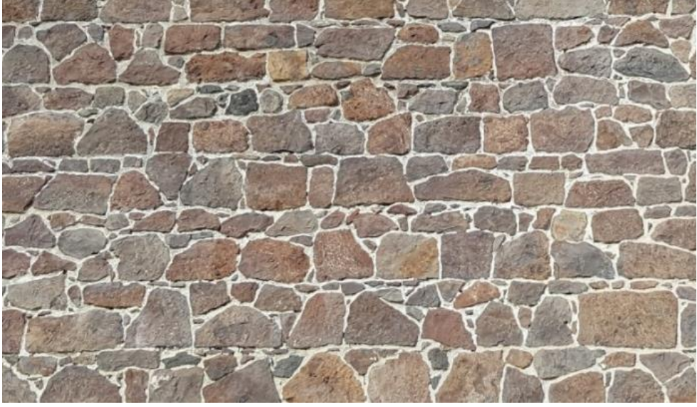
Şekil 3.94: Mecidiye Tabyası kuzey cephesi beden duvarı detayı.
