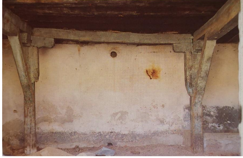
Şekil 4.14: Ahşap Döşeme-Büyük Kiremitlik Tabyası, Erzurum.
