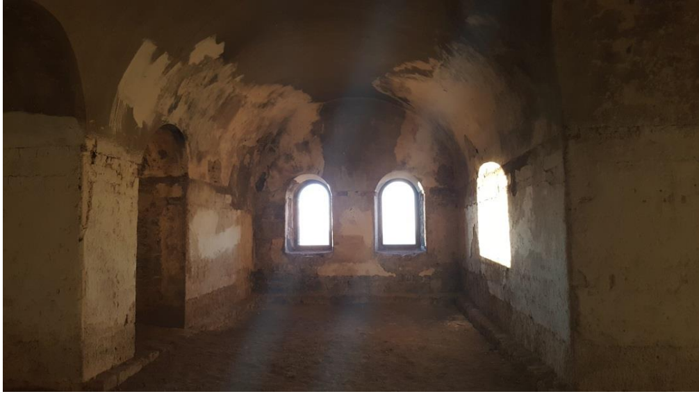
Şekil 3.38: K5 Koğuşu batı duvarı.
