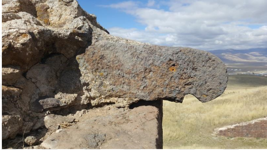
Şekil 3.89: Mecidiye Tabyası doğu cephesi harpuştası.
