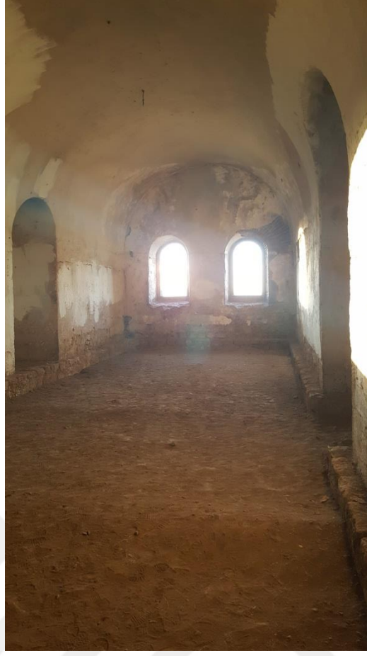
Şekil 3.31: K1 Koğuşu batı duvarı.
