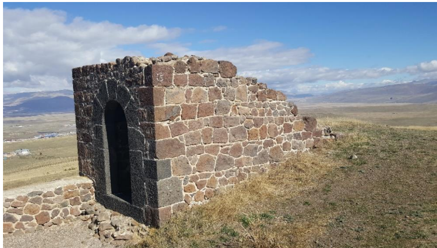
Şekil 3.90: Mecidiye Tabyası Kuzey Top Kulesi Duvarı
