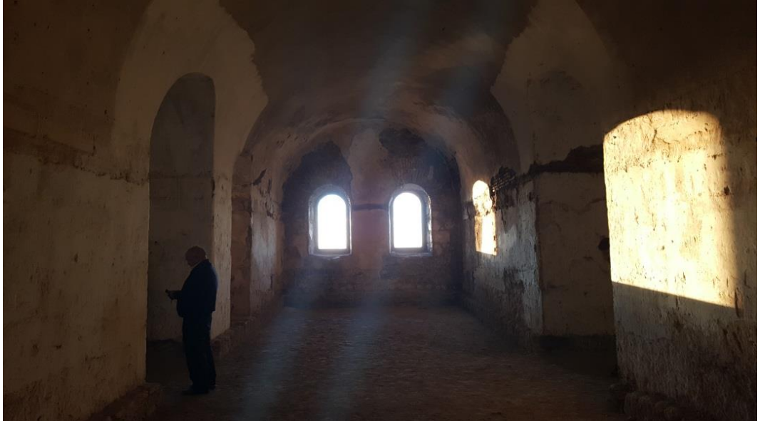
Şekil 3.35: K3 Kođuşu batı duvarı.
