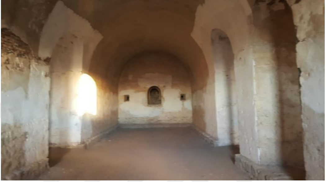
Şekil 3.34: K3 Kođuşu dođu duvarı.
