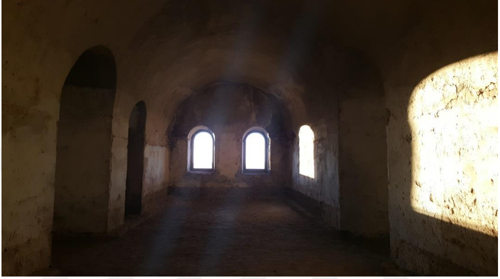
Şekil 3.42: K7 Kođuşu batı duvarı.
