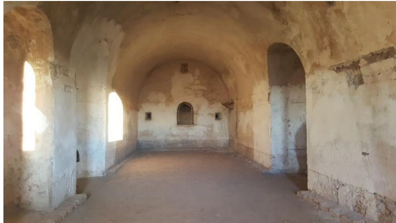
Şekil 3.37: K4 Koğuşu doğu duvarı.
