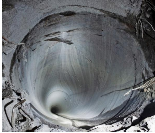
Şekil 2.2 : Baş yukarı delme makinesi ile tamamlanmış bir kuyu.
