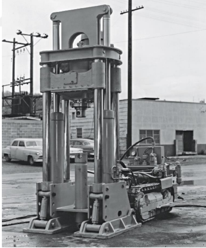
Şekil 2.1 : İlk baş yukarı makinesi Robbins 41R (Atlas Copco Rock Drills AB, 2012).
