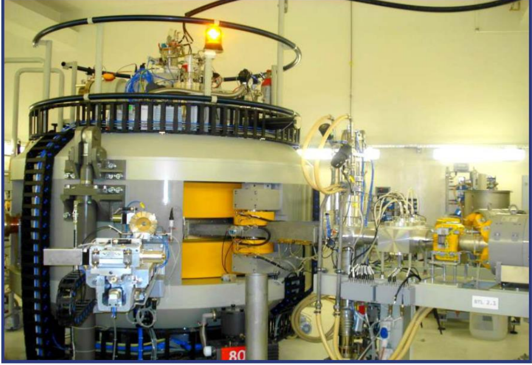
Şekil 2.4 Sarayköy’de kurulu olan CYCLONE-30 siklotron tipi proton hızlandırıcı sistemi (TAEK, 2012)
