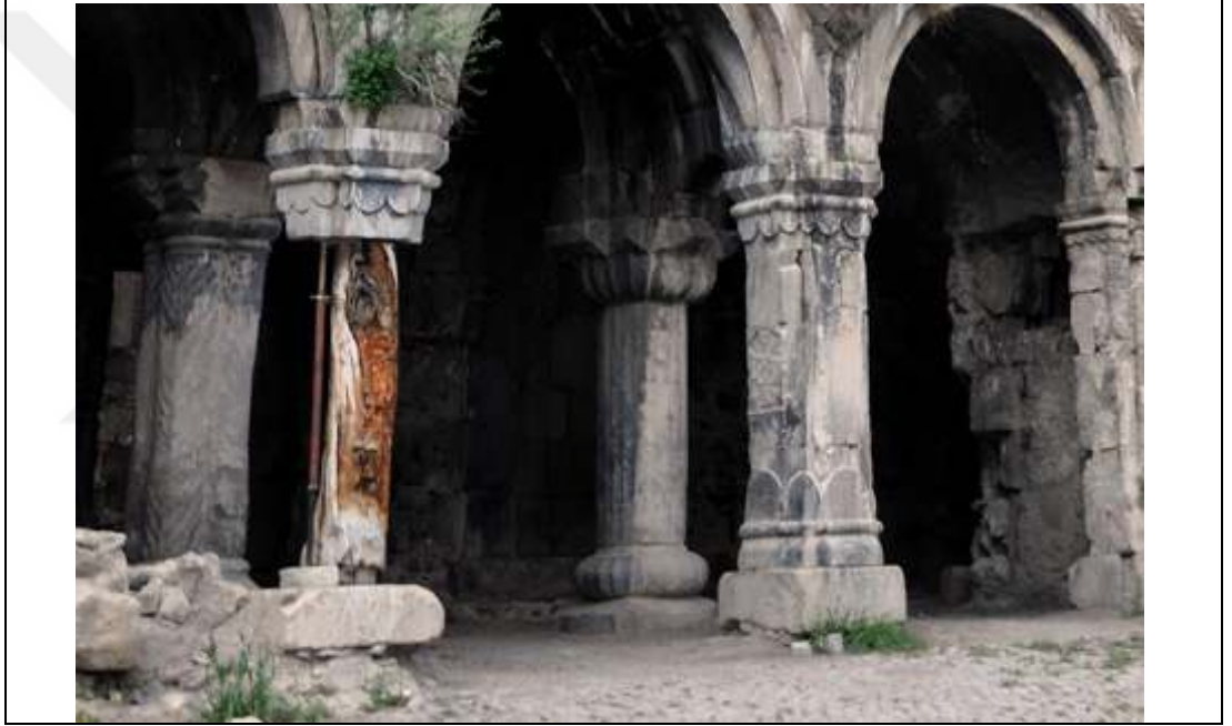
Şekil 5.9: Sonradan eklenen ağaç destek.
