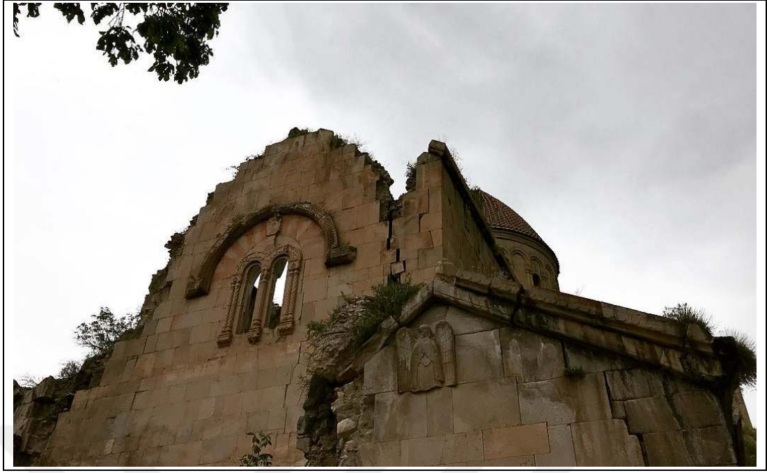
Şekil 5.12: Batı cephesinin düzlem dışı davranış yapan duvarı.
