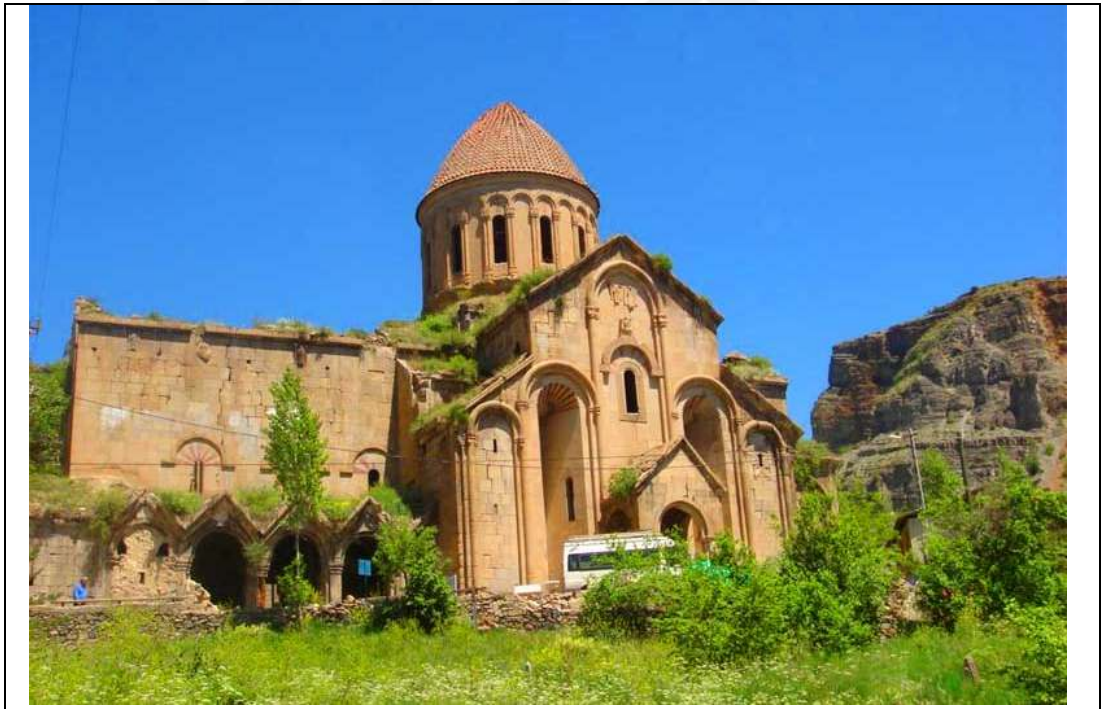
Şekil 5.11: Kilisenin duvarlarının görünüşü.
