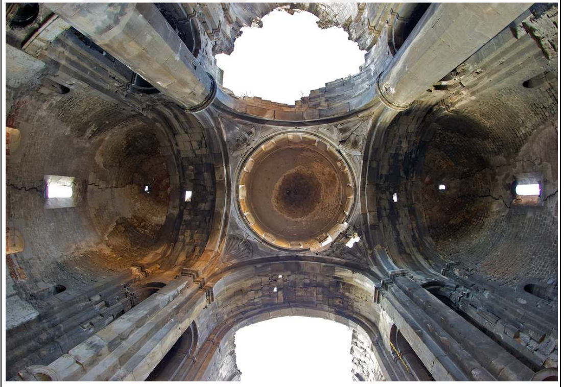
Şekil 5.8: Kemerlerin taşıyıcılığını koruması.
