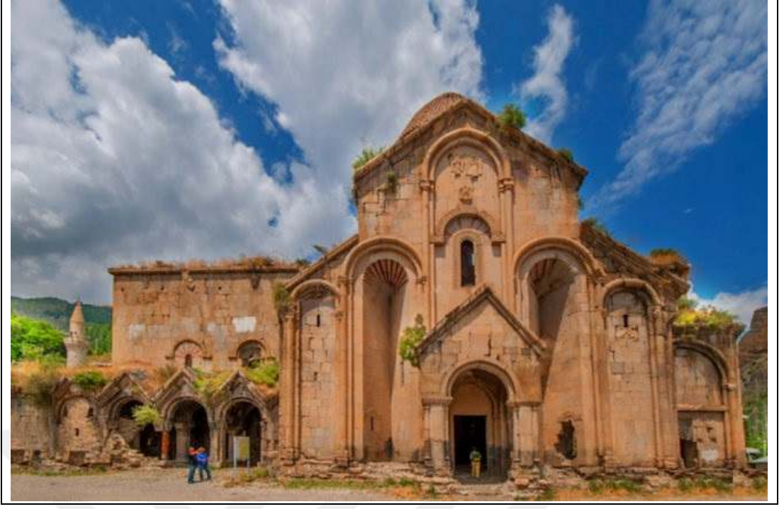
Şekil 5.7: Duvarlarda kullanılan kemerler.
