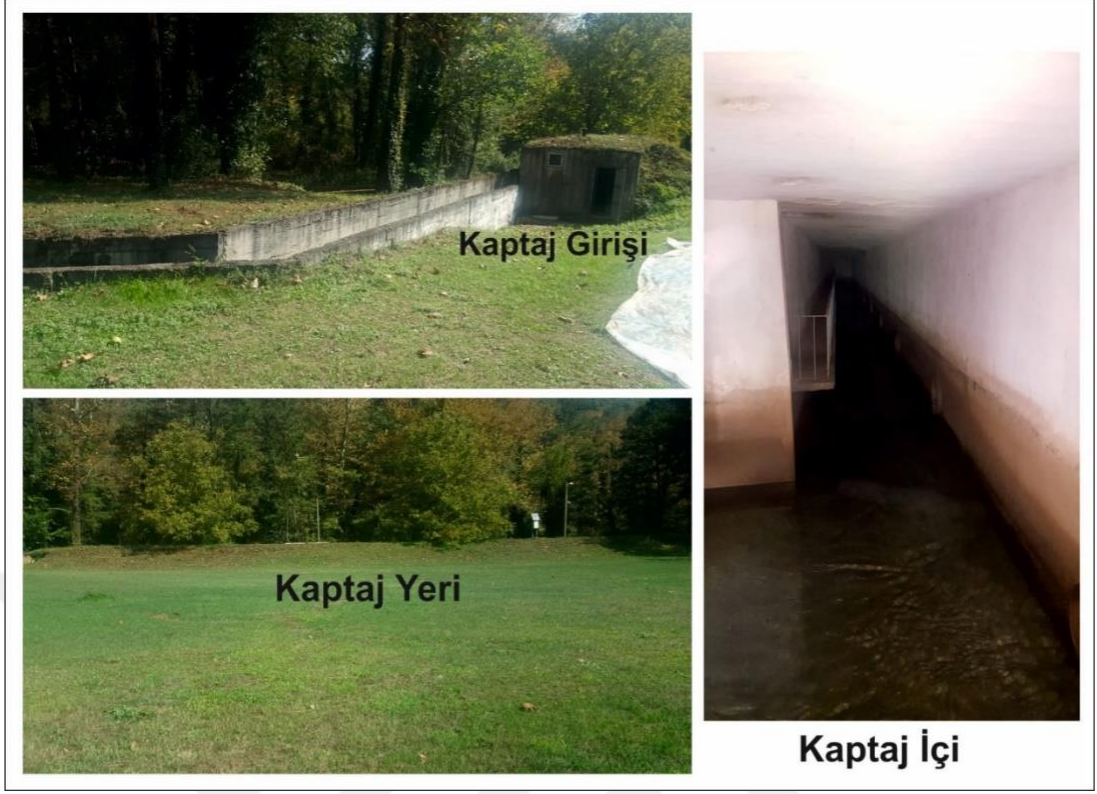
Şekil 5.16. Bahçecik Kaynağı kaptaj girişi, yeri ve içinin görünümü
