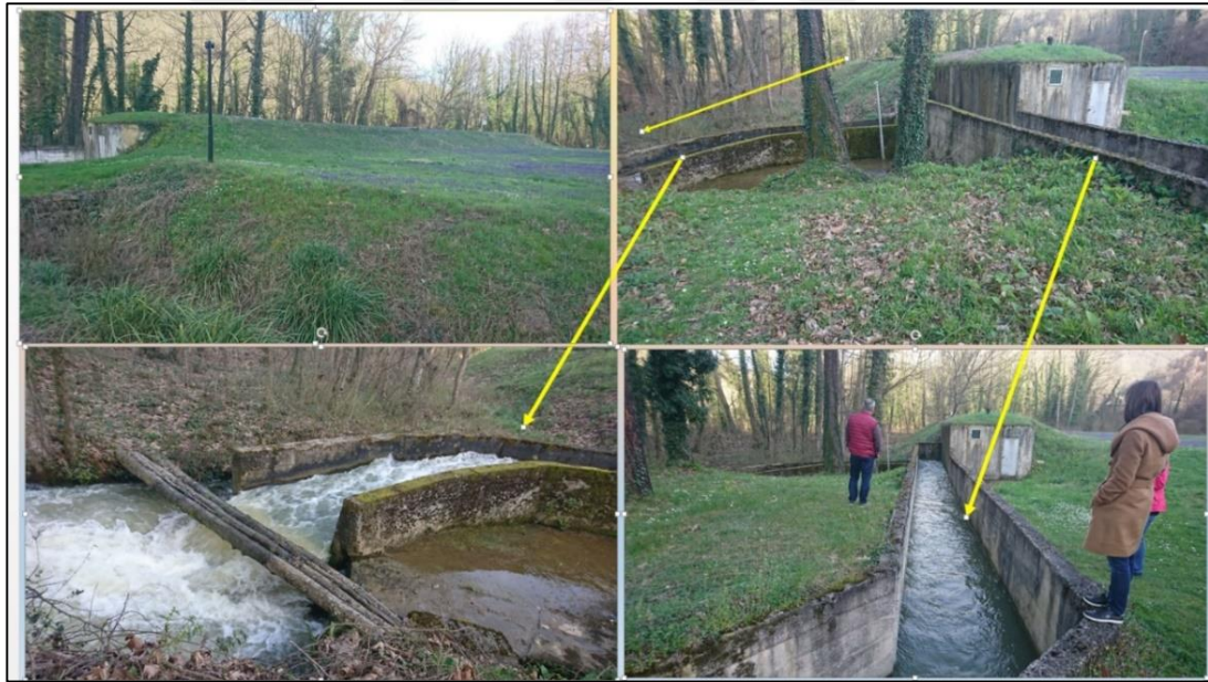
Şekil 5.15. Bahçecik Kaynağı kaptajı su çıkışları görünümü
