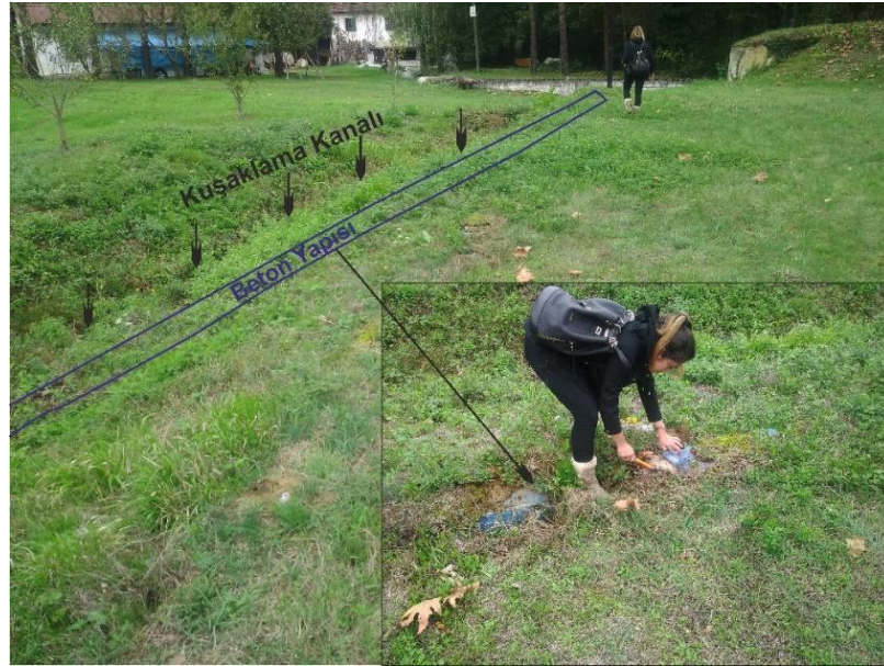
Şekil 5.13. Bahçecik Kaynağı kaptajı kuşaklama kanalı ve beton yapısı
