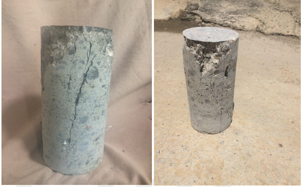
Şekil 5.12 C30 betonu karot 2
