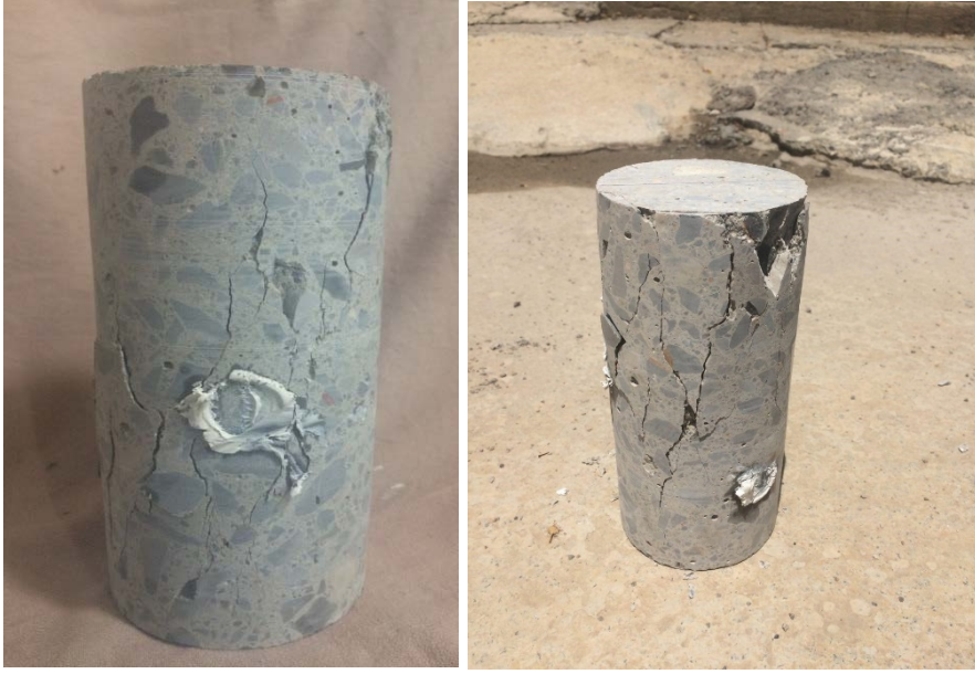
Şekil 5.11 C30 betonu karot 1
