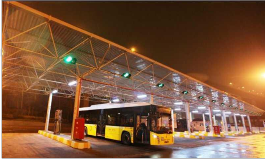
Şekil 4.11 CNG Dolum İstasyonu
