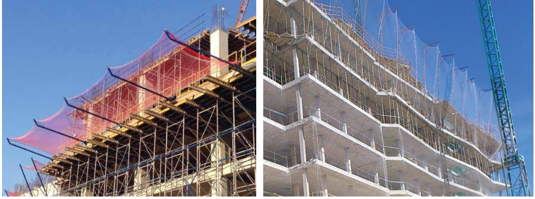
Şekil 2.2. Yapılarda Kullanılan Güvenlik Ağı Örnekleri
