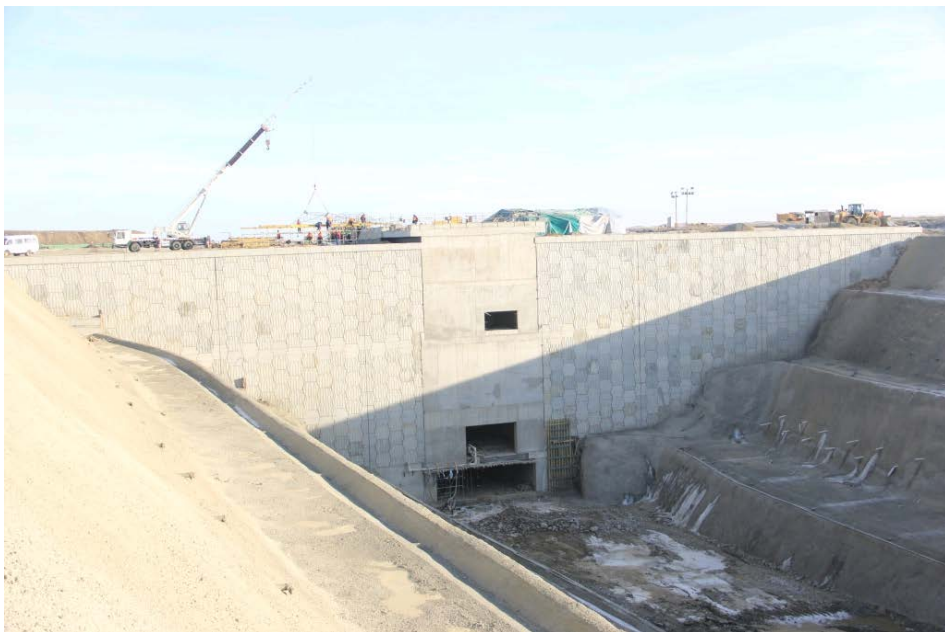
Şekil 5.4 : Toprakarme imalatı sonrasında kırıcı tesisin durumu.
