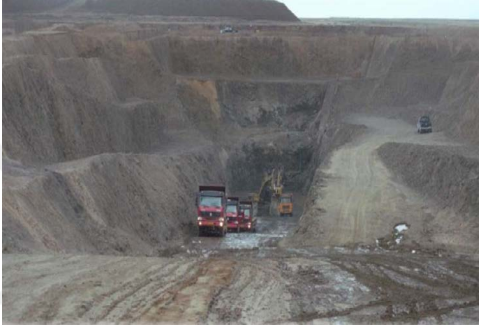
Şekil 5.3 : Toprakarme imalat yapımı öncesi kırıcı tesisin durumu.
