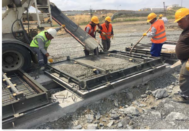
Şekil 2.16 : Prekast panel imalatı (REAŞ, 2019).
