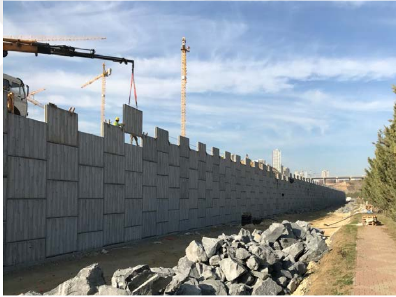
Şekil 2.17 : Prekast panel uygulaması (REAŞ, 2019).
