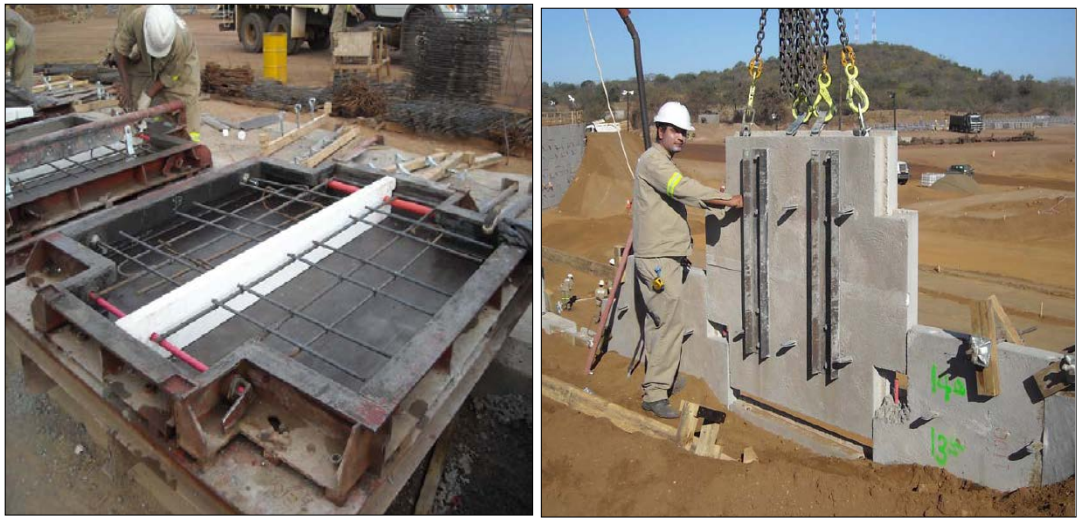
Şekil 5.9 : Panel döküm ve montaj işleri.
