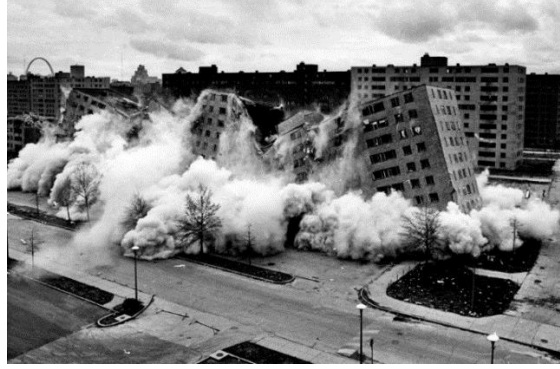
Şekil 2.8 : Pruitt-Igoe Bloklarının Yıkılışı , 1977.
