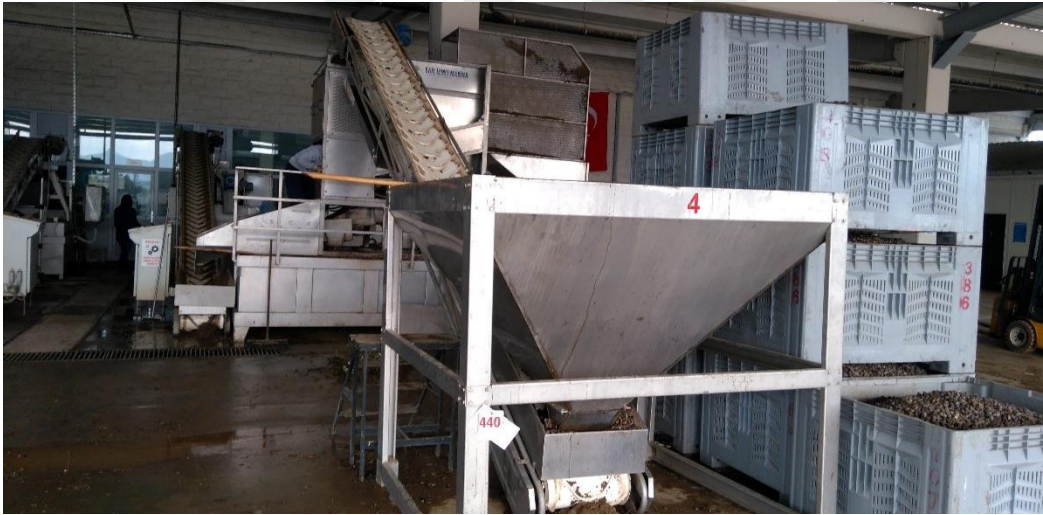
Şekil 1.4. Kontinü zeytinyağı üretim tesisi yükleme ve temizleme üniteleri
