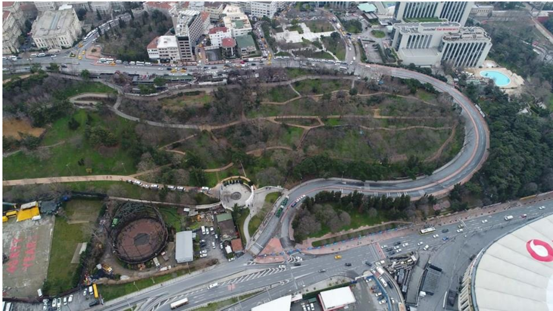
Şekil 2.22. Maçka Tünel Projesi öncesi. Kaynak: https://www.ntv.com.tr/galeri/turkiye/macka-parkinda-agaclarin-sokulmesine-baslandi,VptIn1DYK0yIOE5Jt2Vk5g/XFTZhEXLgEqTSSTosT0z5Q
