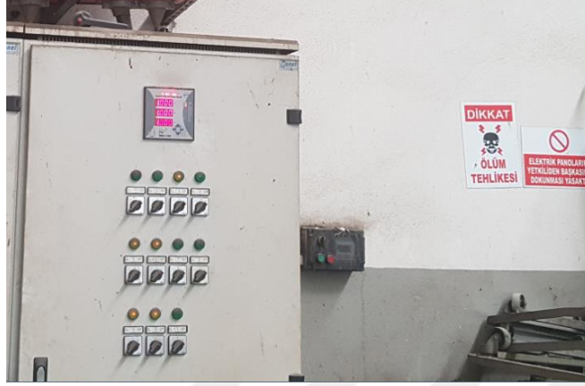
Şekil 4.5. Kapalı pano kapakları ve levhalar
