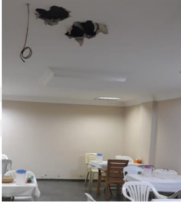
Şekil 4.3.Yemekhane tavanında açıklık
