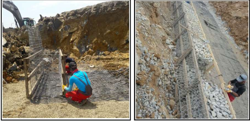
Şekil 4.54. İlk sıra ünite, kalıp kurulumu ve taş dolumu
