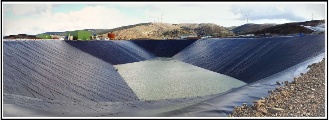
Şekil 4.8. Bir atık toplama alanında jeomembran uygulaması
