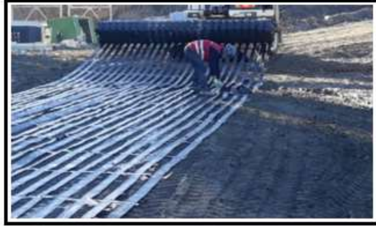
Şekil 4.30. 200 kN/m jeogrid uygulama aşamasından bir görünüm
