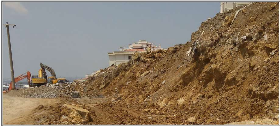
Şekil 4.25. Kazı çalışmalarından bir görünüm
