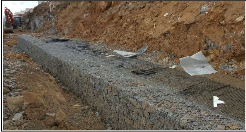
Şekil 4.55. İlk sıra montaj tamamlanması
