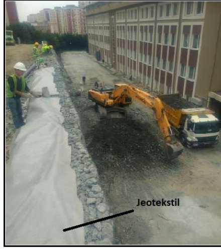
Şekil 4.2. Bir istinat duvarının görünür yüzey ve arka dolgusu arasında filtrasyon ve koruma amaçlı jeotekstil uygulamasından bir görünüm
