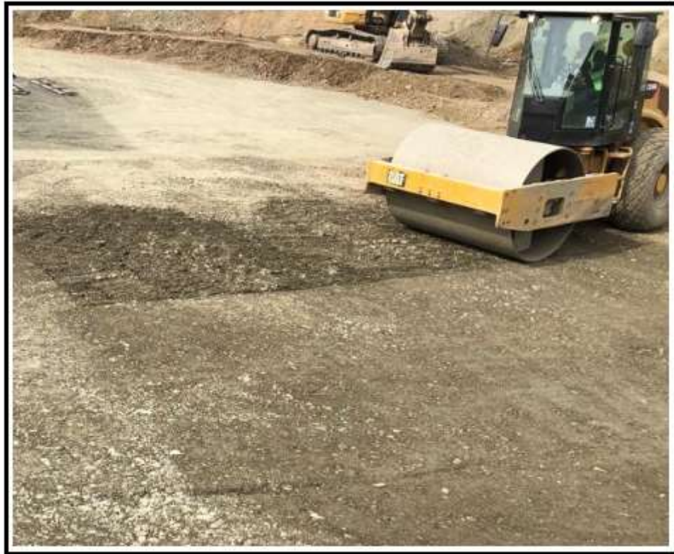
Şekil 4.27. Duvar arka dolgusunun uygulanmasından bir görünüm
