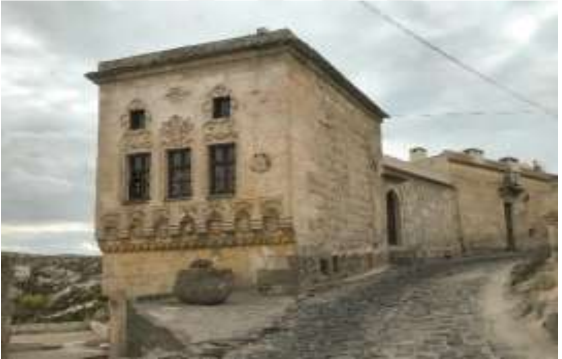
Resim 295.-296.-297.-298. Uçhisar Yığma Tekniğindeki Yapılar (Yusuf Budak'tan)
