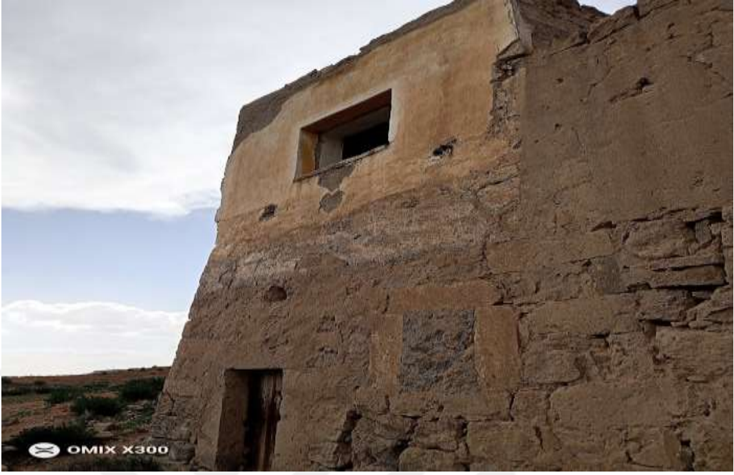
Resim 63. 8 No.lu Ev Genel Görünüm (Ömer İçirgin)
