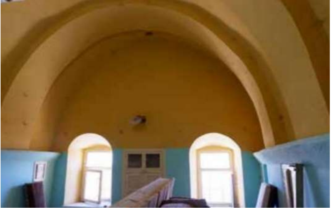
Resim 324. Demirci İsmail Ay Köy Odası Pencere ve Gömme Dolabın Bulunduğu Yerdeki Tol Kemer (Erkan Aygör'den)
