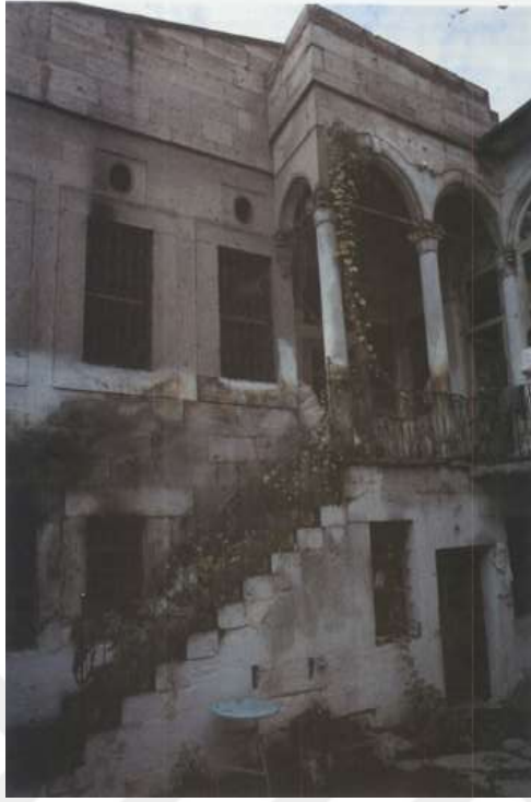
Resim 431. Kayseri Çayırağası Evi Cephesi (Vahit İmamoğlu'ndan)
