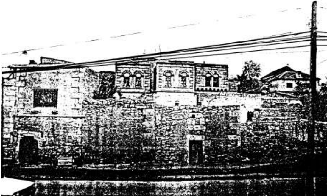
Resim 442. Demirci'deki Çeşitli Evlerin Düşey Köşe Taş Cepheli Görünümleri (Zekai Erdal'dan)
