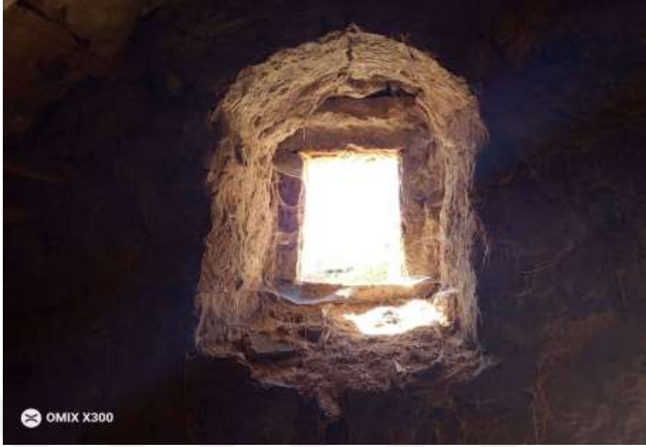
Resim 11. 1 No.lu Ev Alt Kat Samanlık ve Tandır Evi'nin Sivri Kemerli Penceresi (Ömer İçirgin)
