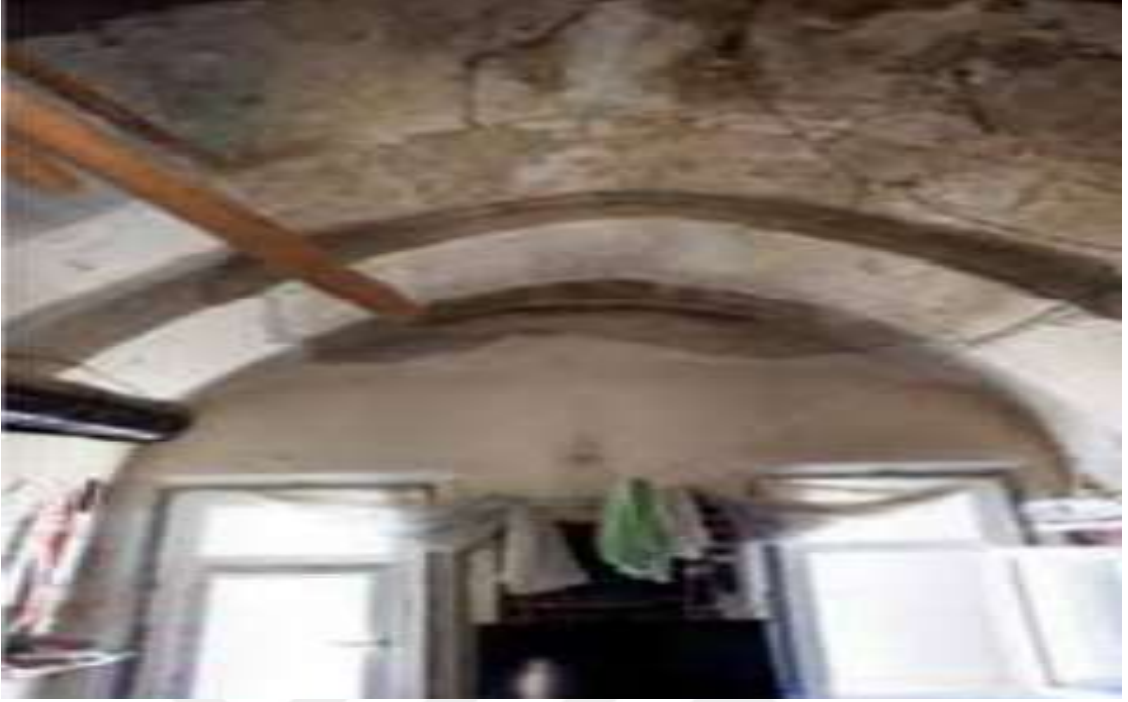
Resim 325. Demirci Osman Koçak Evi Oda Tavanı Atkı Kemer Tonoz (Erkan Aygör'den)
