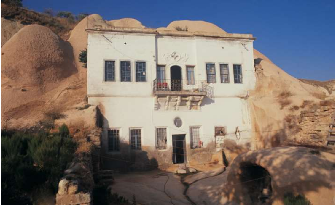
Resim 318. Kaya Oyma ve Yığma Teknikleri İle Yapılmış Ürgüp Arslanlı Ev ( https://www.arkitera.com/gorus/kapadokya-mimarisinin-binlerce-yillik-oykusu/Murat E. Gülyaz'dan )
