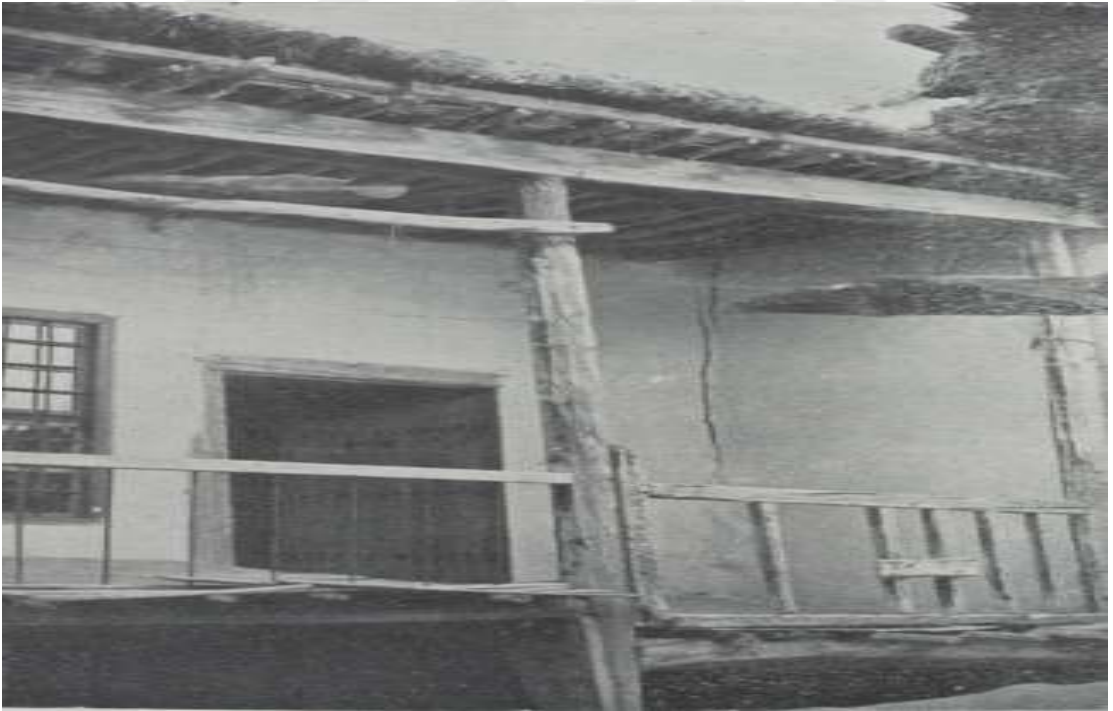
Resim 333. Konya Sedirler Caddesi'nde Bulunan Bir Evin Ahşap Kirişlemeleri (Celile Berk'ten)
