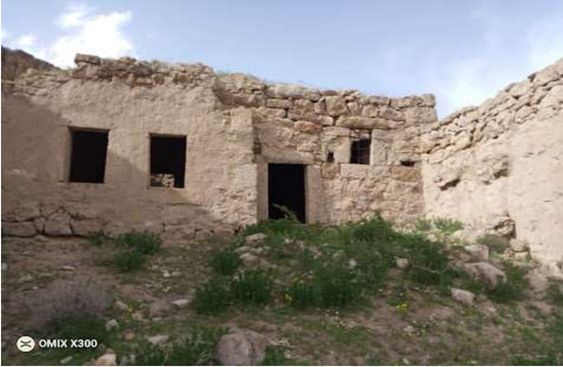
Resim 53. 7 No.lu Ev Genel Görünüm (Ömer İçirgin)
