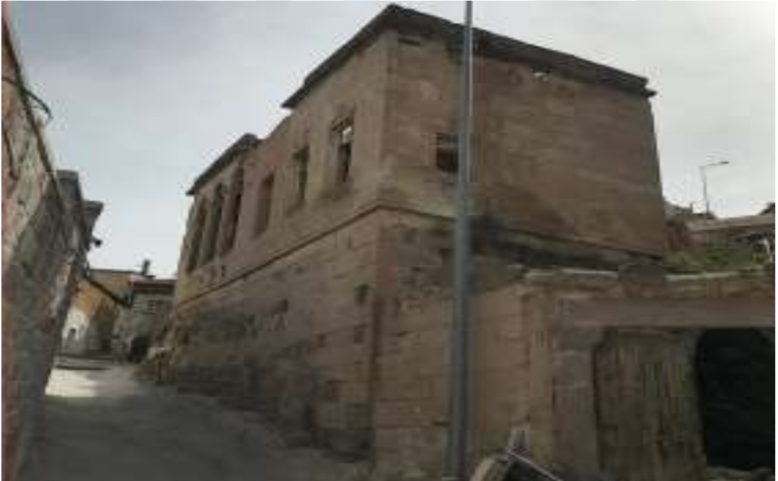
Resim 320. Uçhisar'da Kaya Oyma ve Yığma Teknikleri İle Yapılmış Bir Ev (Pınar Başak Tongal'dan)
