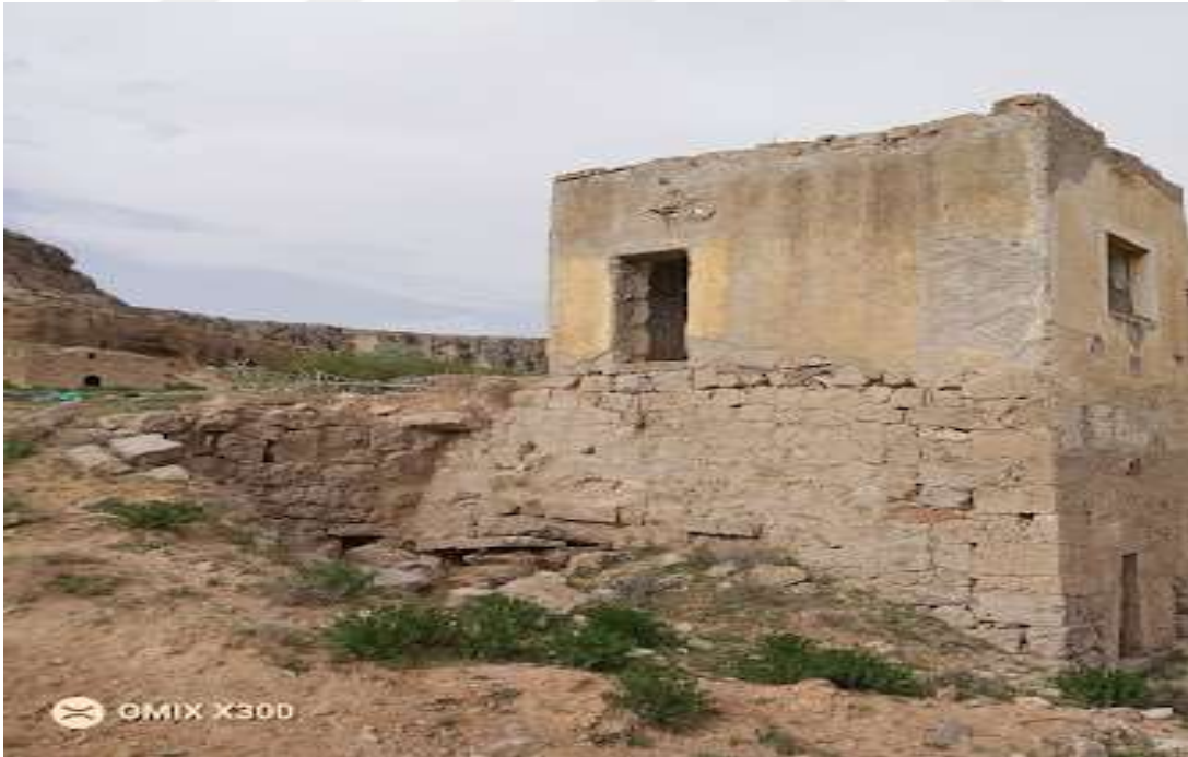
Resim 64. 8 No.lu Ev Yandan Görünüm (Ömer İçirgin)
