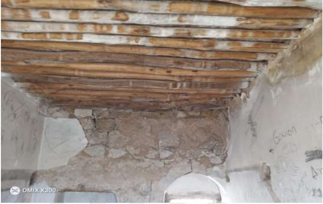
Resim 141. Köy Odası Ahşap Kirişleme (Ömer İçirgin)
