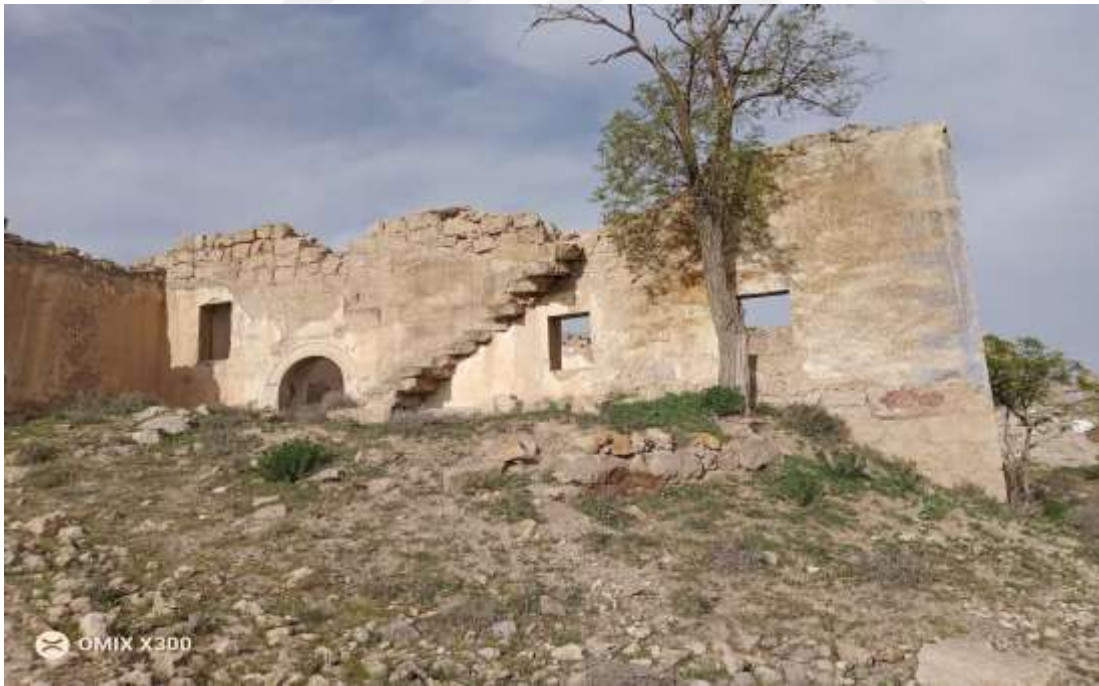
Resim 146. Kızılkaya Köyü Eski Camii Genel Görünüm (Ömer İçirgin)
