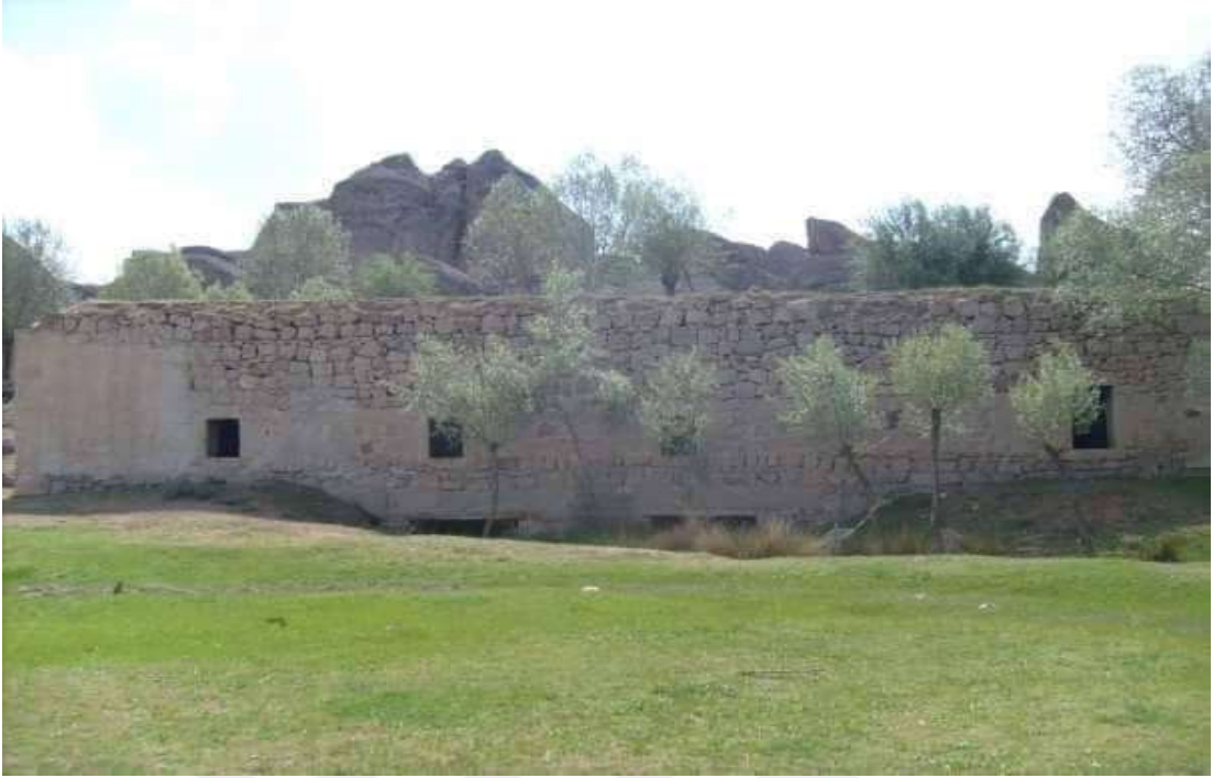
Resim 163. 1 No.lu Değirmen Dış Cephe Görünüm (Ömer İçirgin)
