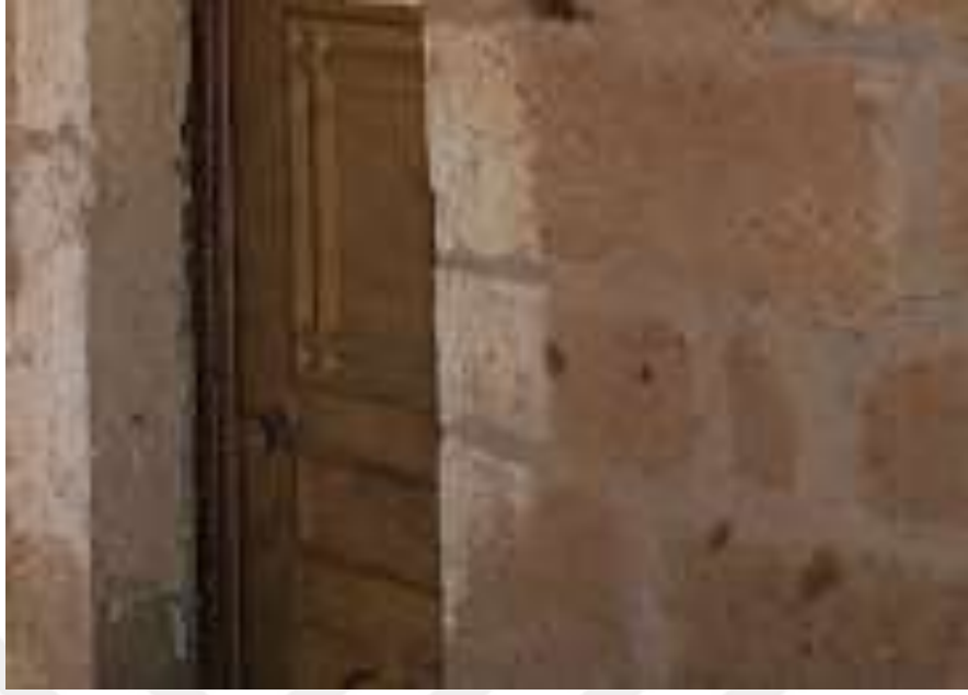
Resim 39. 4 No.lu Ev Dış Kapı (Ömer İçirgin)
