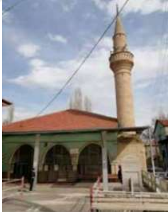
Resim 452. Demirci Çarşı Camii Marsilya Tipi Kiremit Kaplı Üst Örtü (Erkan Aygör'den)
