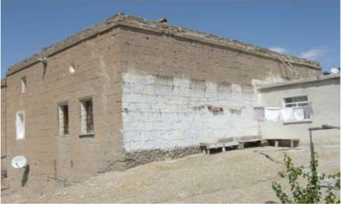
Resim 290. Güzelyurt'un Tek Katlı, Kesme Taştan Yapılmış Bir Evi ( https://aksaray.ktb.gov.tr/Eklenti/7714,kegy1pdf.pdf?0 )
