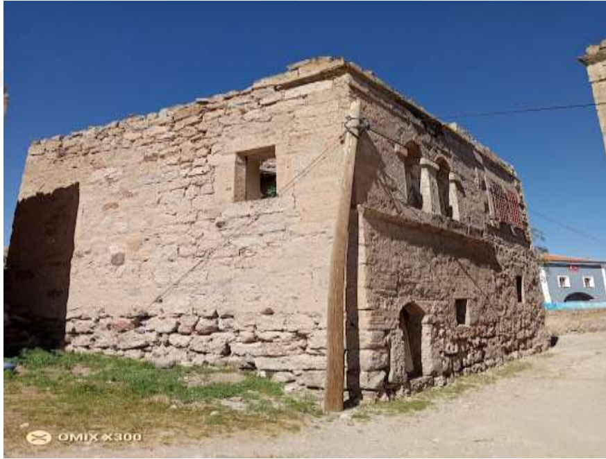
Resim 36. 4 No.lu Ev Genel Görünüm (Ömer İçirgin)
