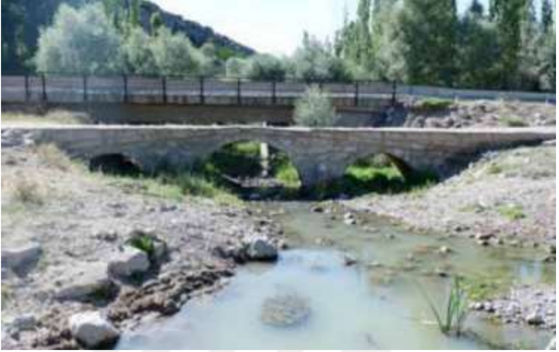
Resim 545. Aksaray Demirci Kocataş Köprüsü (Erkan Aygör'den)
