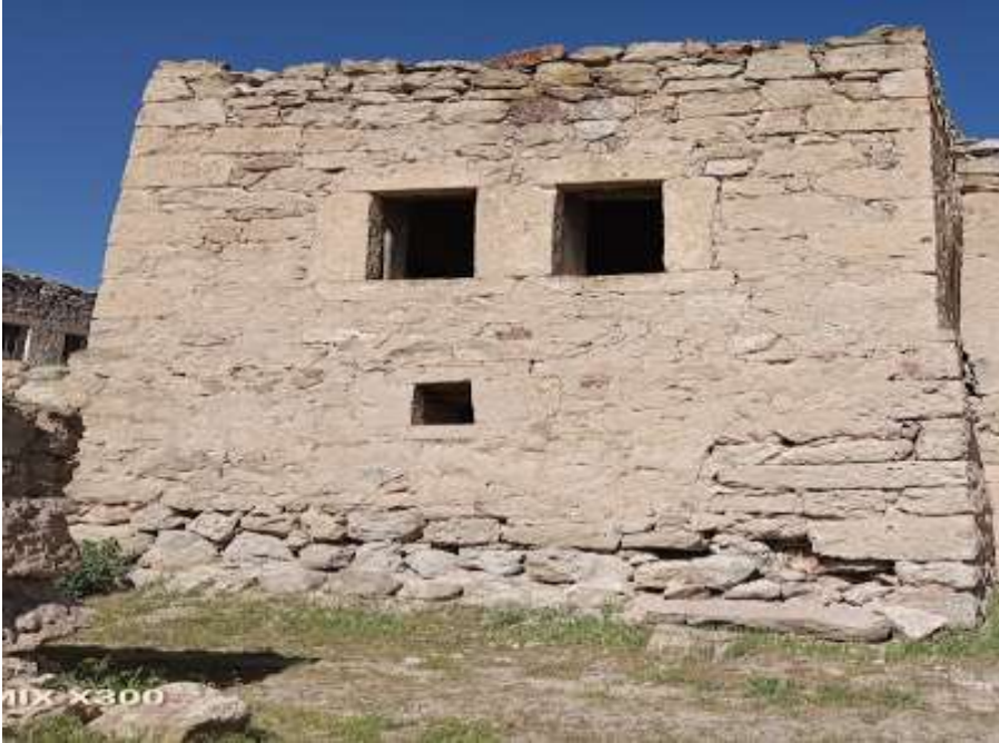
Resim 28. 3 No.lu Ev Yandan Görünüm (Ömer İçirgin)
