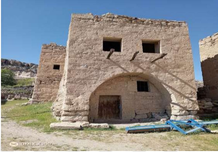
Resim 27. 3 No.lu Ev Genel Görünüm (Ömer İçirgin)
