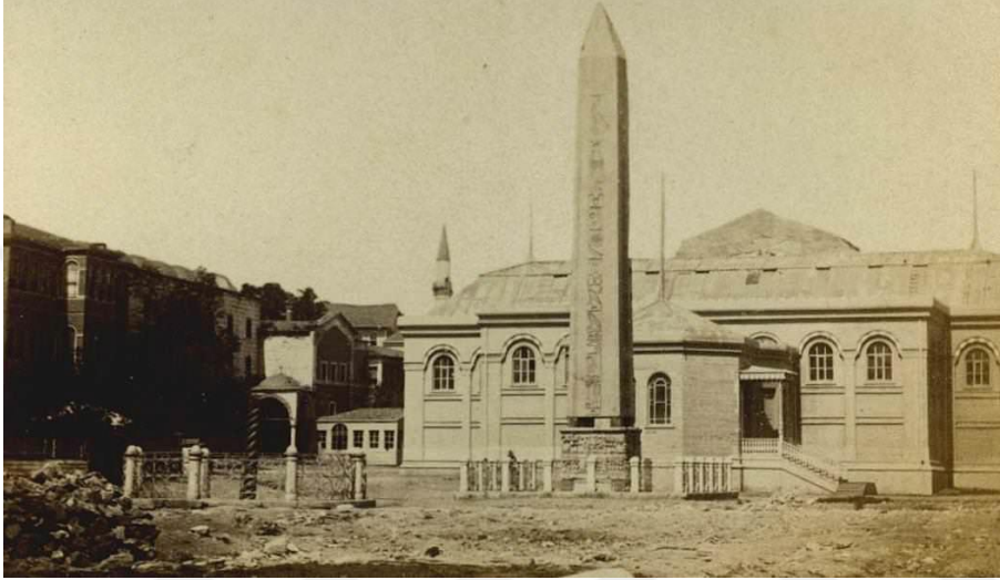
Şekil 4.49: Theodosius Taşı'nın Önüne İnşa Edilen Sergi Binası, 1863 (Url-90),
