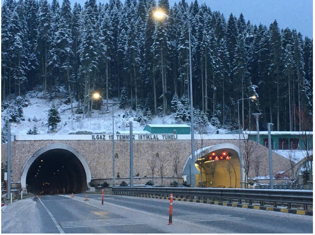
Şekil 5.3 Çalışma alanında bulunan Ilgaz Tüneli'nden görünüm (Fotoğraf: Büşra KALLECİ)
