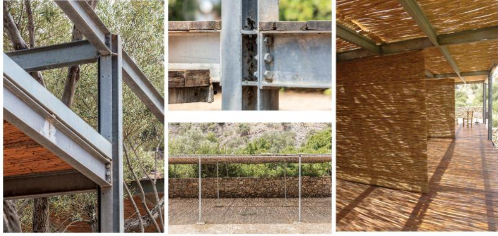
Şekil 4.65: Mazı evinin çelik konstrüksiyonu ve yöredeki kamışlar aracılığıyla oluşturulan yarı açık alanlar. (Sayın,2019)
