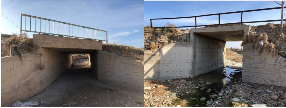
Şekil 3.4 Çalışma alanında bulunan menfezlere ait görüntü
