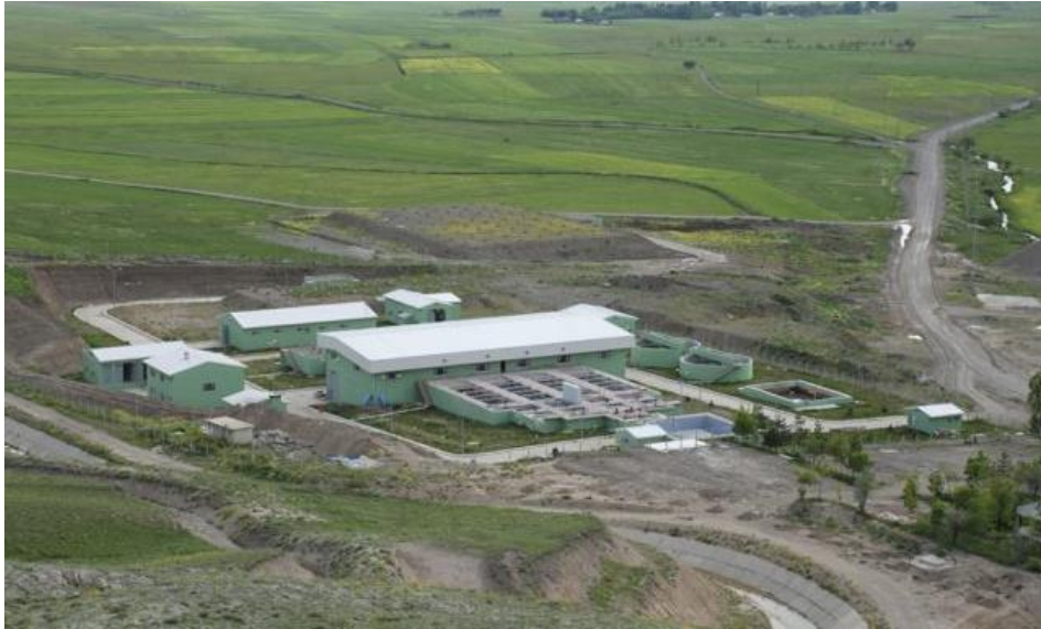
Şekil 5. Yazıcı Barajı arıtma tesisi
