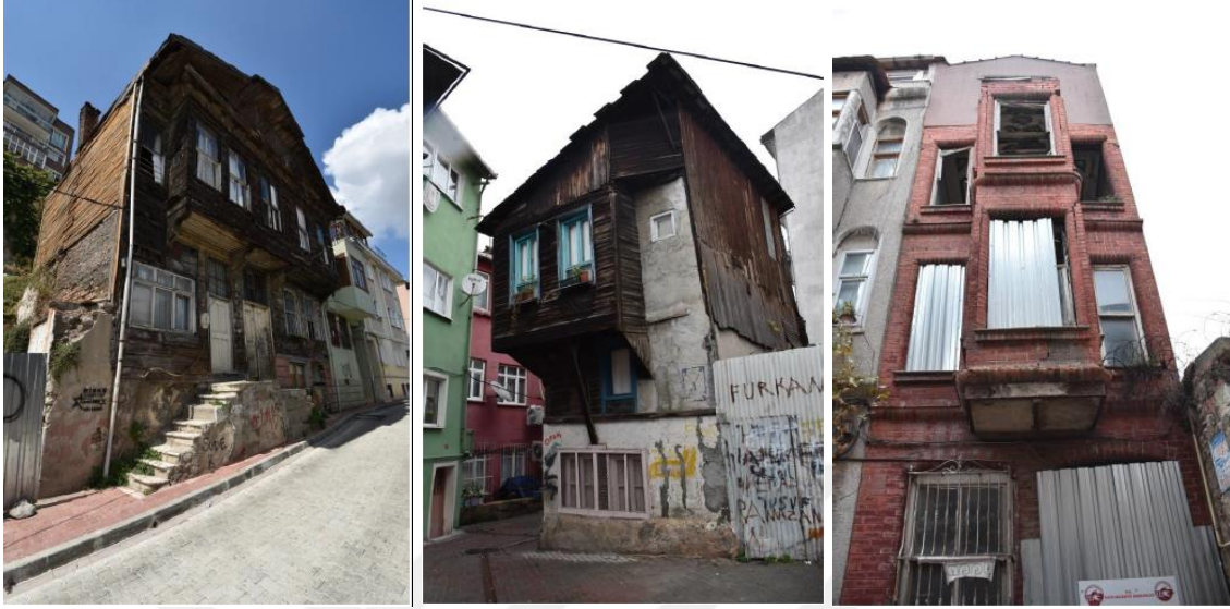
Şekil 3.108 Hafif yapısal problem görülen yapılar (Aytek, 2022)
