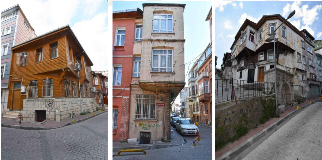
Şekil 3.85 Mercimek Sokak, Mesneviyhane Sokak ve İncebel Sokak köşe parsellerinde görülen yapı örnekleri (Aytek, 2022)
