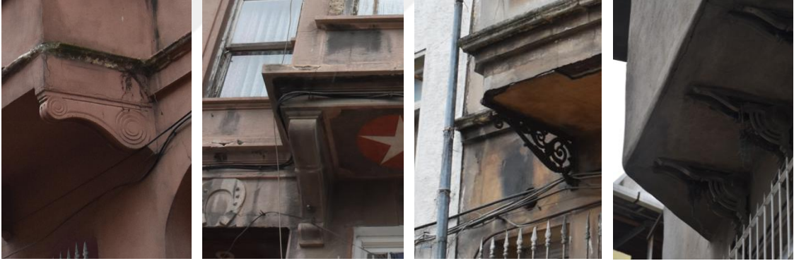
Şekil 3.63 Çıkma altlarında taş payanda ve demir paraçol örnekleri (Aytek, 2022)
