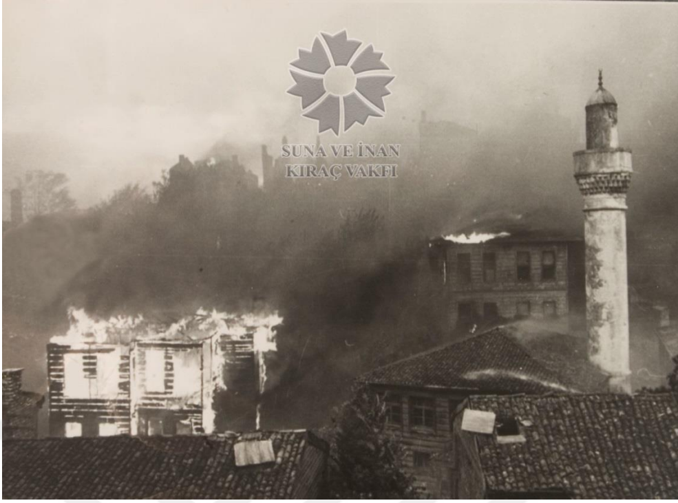
Şekil A.2 Ahşap vaziyeti ile Cafer Subaşı Mescidi ve 2279 Ada'da yitirilen ahşap yapılar. Muhtemelen 1941 Patrikhane Yangını esnasında (İstanbul Araştırmaları Enstitüsü Arşivi)
