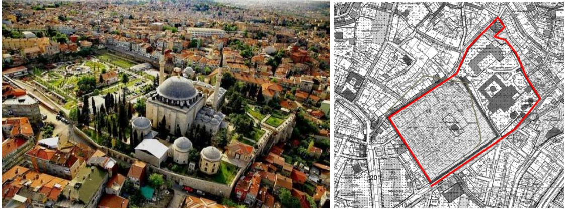
Şekil 3.131 Sultan Selim Külliyesi (URL-4) ve Aspar Sarnıcı'nın oluşturduğu 1. Derece Koruma Bölgesi (İBB, 2012)
