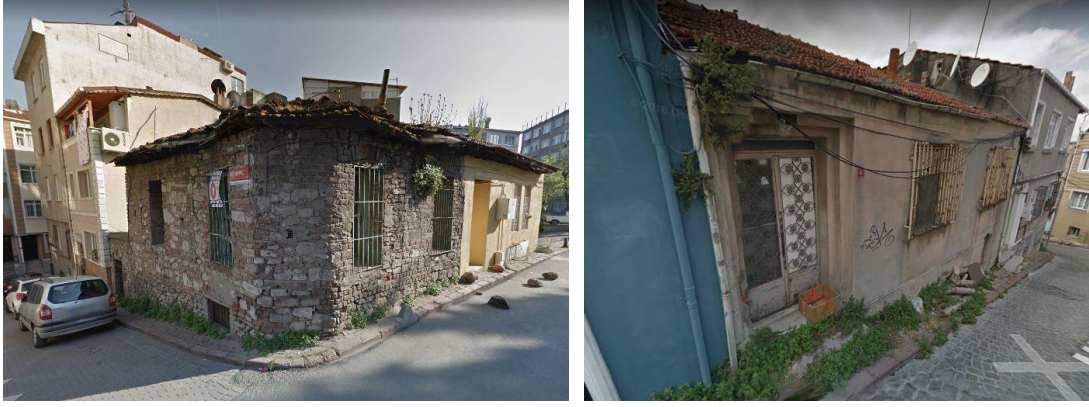
Şekil 3.43 Yitirilmiş Tek katlı yapı örnekleri (Google maps sokak görünümü, 2014)
