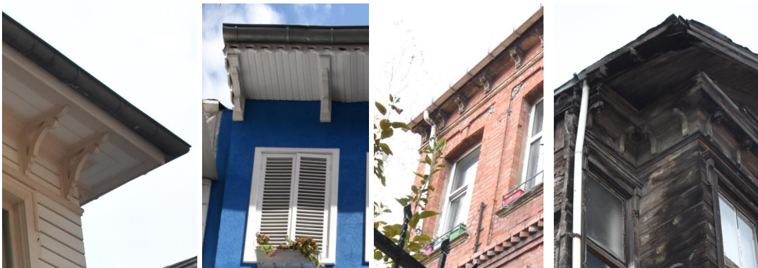
Şekil 3.66 Saçaklarda görülen çeşitli malzemedен fûruş örnekleri (Aytek, 2022)
