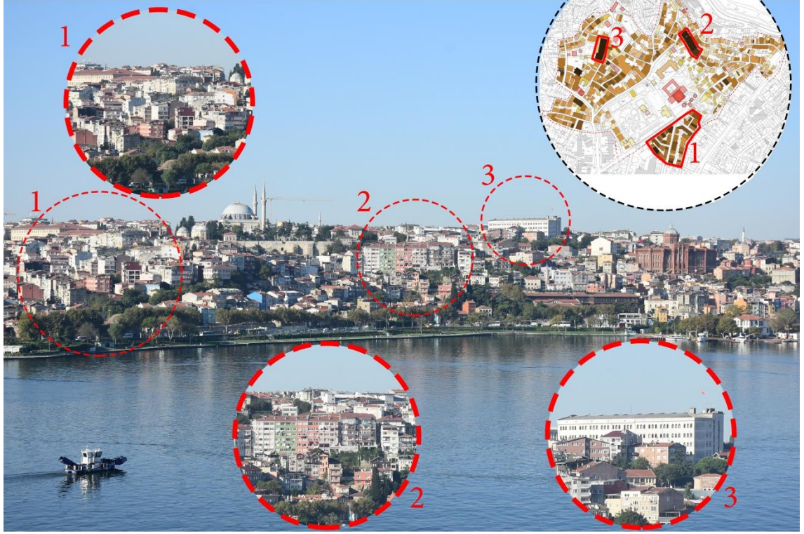
Şekil 3.92 Kat irtifası yönünden aykırı yapıların Haliç alan silüetine olumsuz etkisi (Aytek, 2022)
