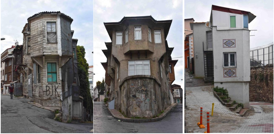
Şekil 3.84 Soğuk Tulumba Sokak ve İncebel Sokak dar açılı parsellerde görülen yapı örnekleri (Aytek, 2022)
