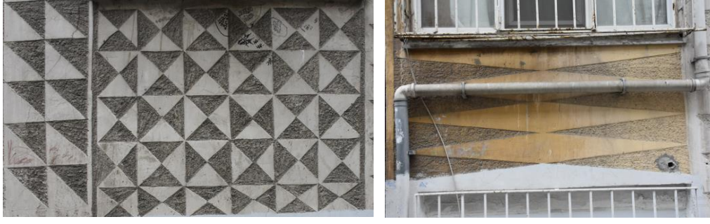
Şekil 3.69 Apartman cephelerinde taraklı sıva ile elde edilmiş geometrik desenler (Aytek, 2022)
