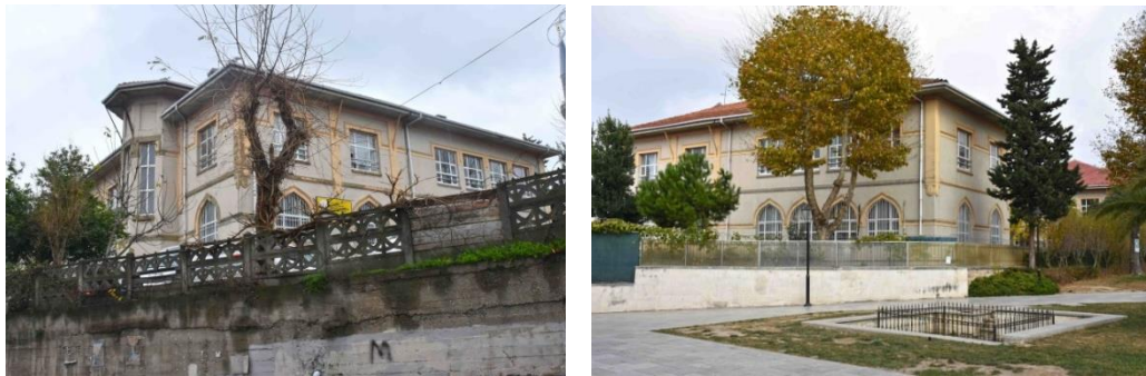
Şekil 3.33 I. Adülhamid Medresesi (Sultan Selim Lisesi) cephe görünümleri (Aytek, 2022)
