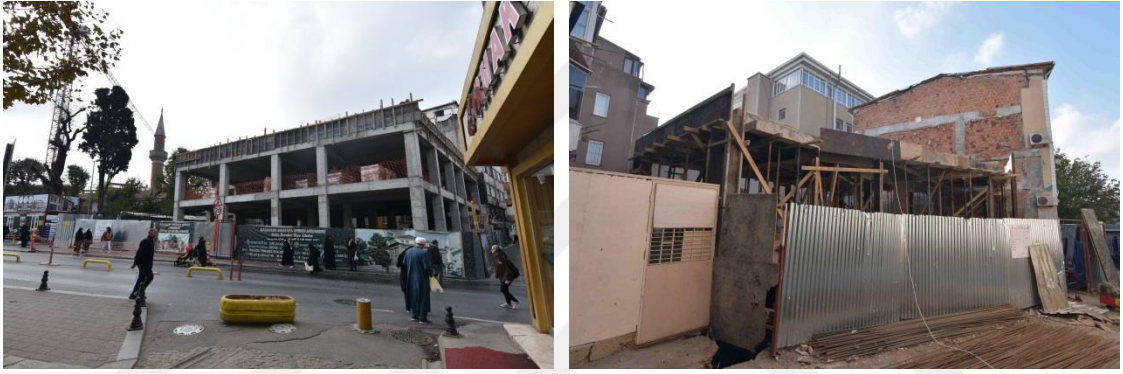
Şekil 3.102 Darüşşafaka Caddesi ve İsmailağa 2. Çıkma. İnşaat Halindeki Yapılar (Aytek, 2022)
