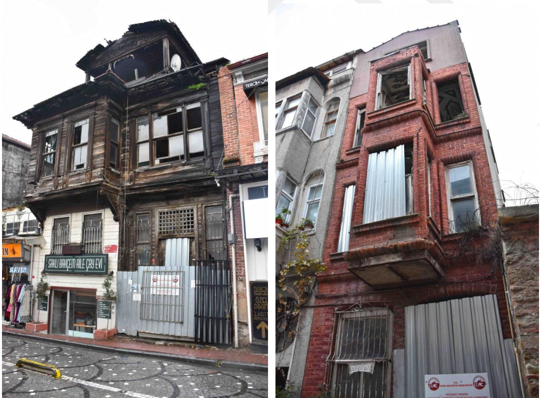
Şekil 3.101 Sultan Selim Caddesi ve Murat Molla Sokak, Kullanılmayan Yapılar
