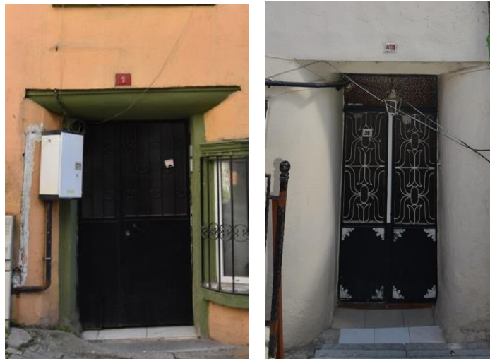
Şekil 3.61 Köşeleri yuvarlatılmış söveli apartman girişleri (Aytek, 2022)
