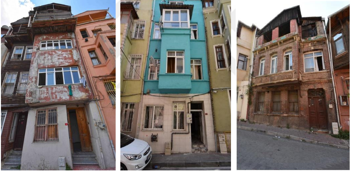
Şekil 3.116 Özgün cephe organizasyonu kısmen okunur durumda olan yapılar (Aytekin, 2022)
