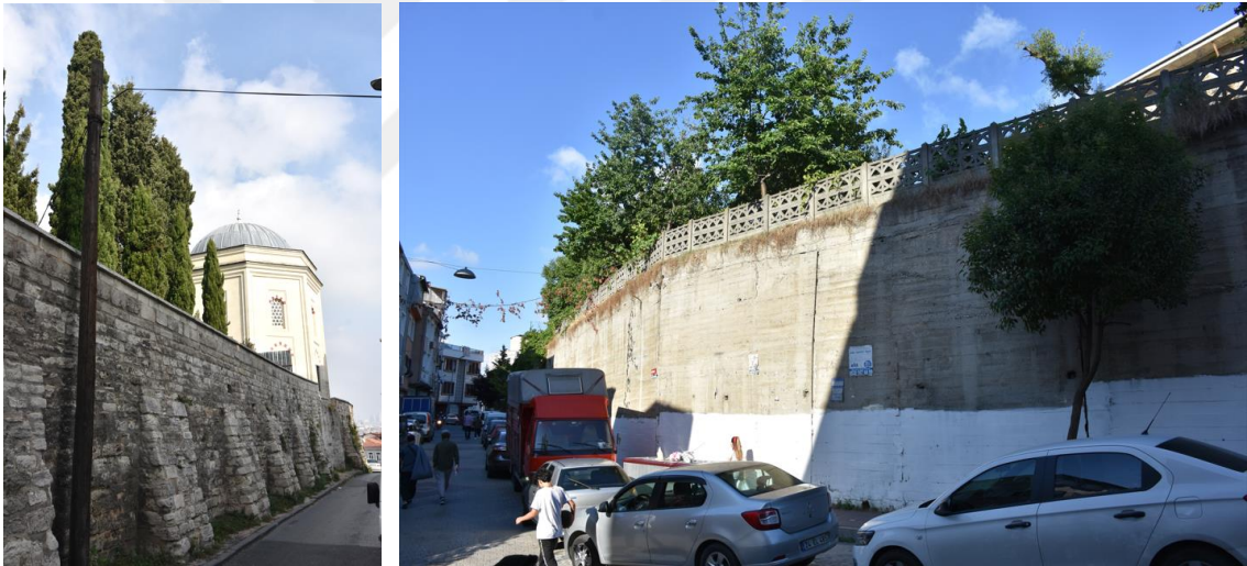
Şekil 4.3 Alanda görülen özgün ve betonarme istinat duvarları (Aytek, 2022)
