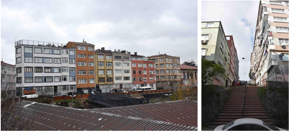
Şekil 3.93 Alan içerisinde bulunan zemin+4 kat ve üstü yapılar (Aytek, 2022)
