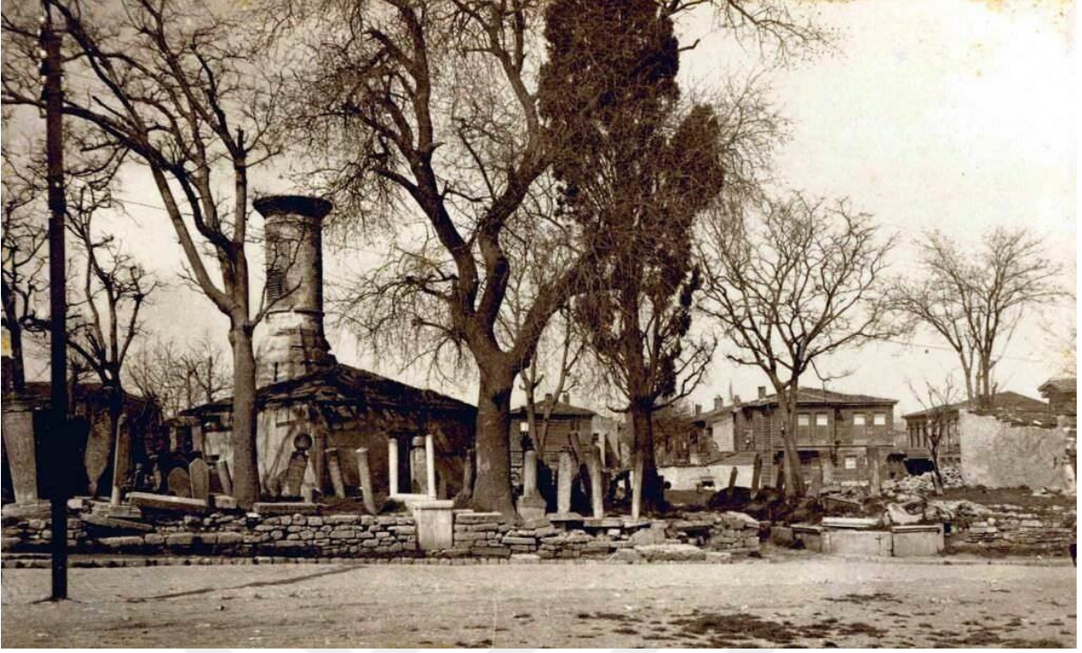
Şekil A.2 18-Daruşşafaka Caddesi'nden Kovacı Dede Mescidi'ne bakış. 1371 Ada etrafında yitirilen ahşap konutlar (URL-4)
