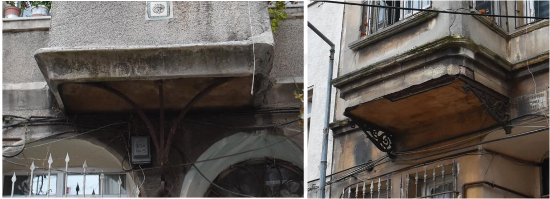
Şekil 3.65 Profilli sıva ile vurgulanmış kat silmeleri (Aytek, 2022)
