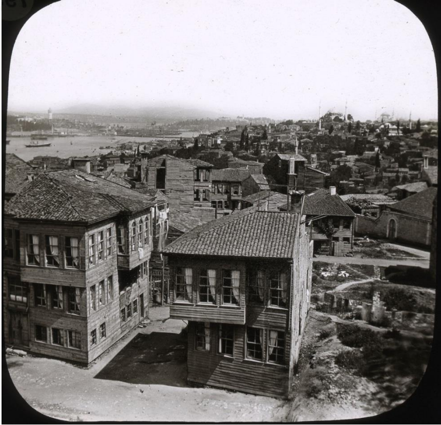
Şekil A.2 Balat yönünden Sultan Selim tepesine bakış (İstanbul Araştırmaları Enstitüsü)
