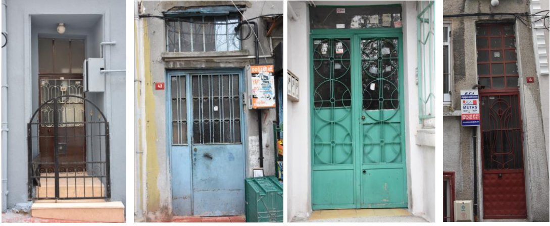
Şekil 3.59 Apartman girişlerinde görülen demir kapı örnekleri (Aytek, 2022)
