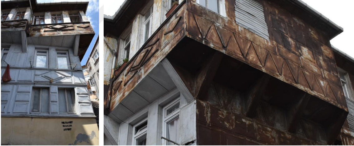
Şekil 3.68 Ahşap evde geometrik motifli teneke kaplama (Aytek, 2022)
