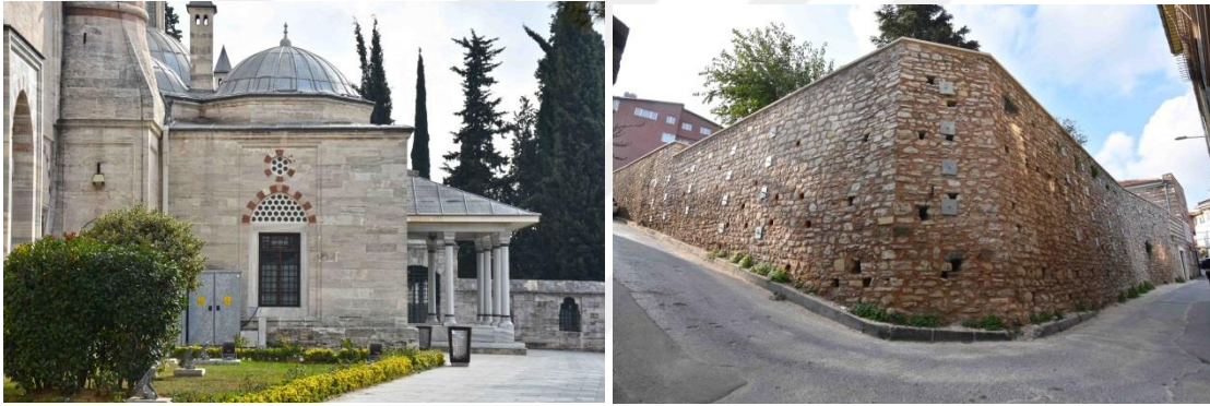
Şekil 3.104 Kesme taş ve moloz taş malzeme kullanılan yığma yapı örnekleri (Aytek, 2022)
