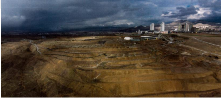
Şekil 4.25. Mamak 2. Sınıf Atık Düzenli Depolama Tesisi
