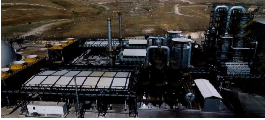
Şekil 4.28. Gazlaştırma/ Yakma Tesisi
