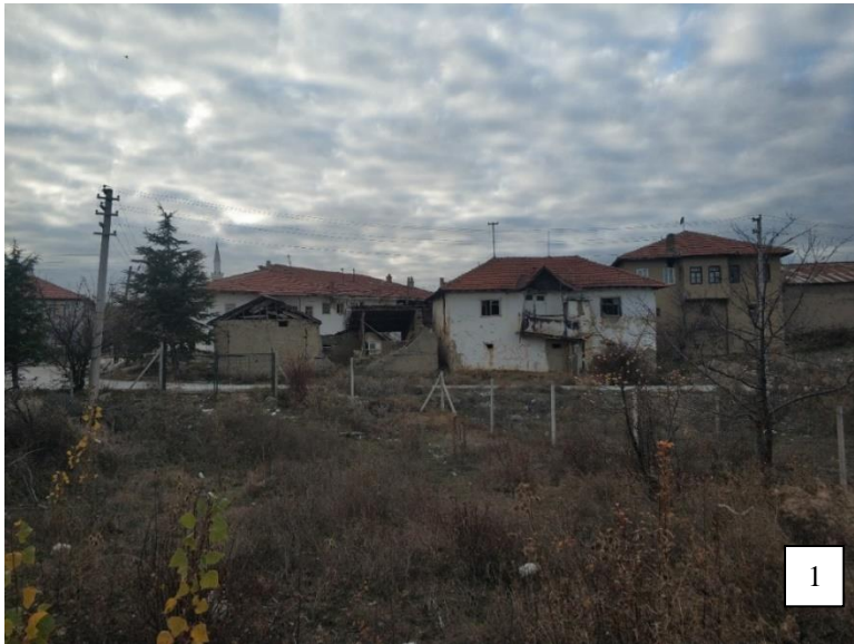
Resim 6.9. 2022 yılında eski merkezin durumu (Resim paftası 1 nolu resim)
