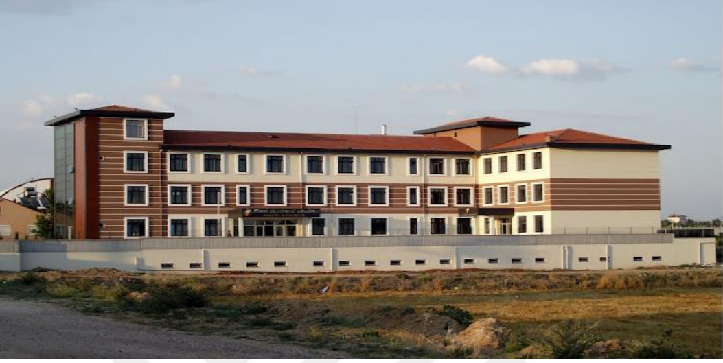
Resim 1.2. F.T. Özel lisesi cephe görüntüsü
