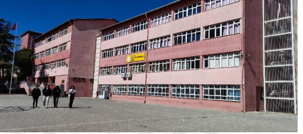
Resim 1.3. A.A. Özel lisesi cephe görüntüsü
