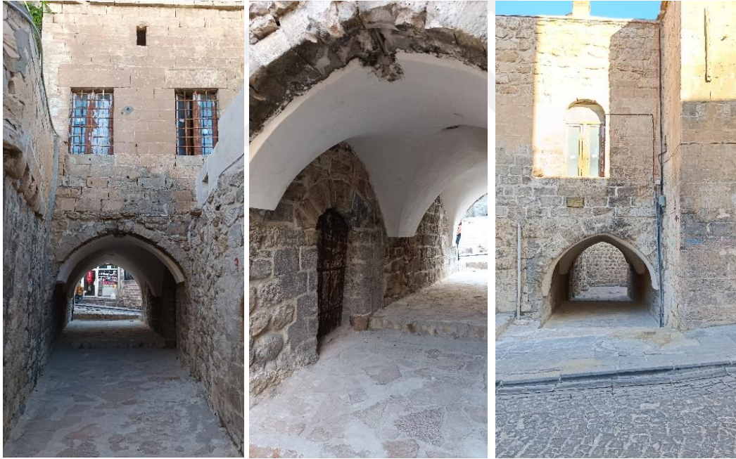
Fotoğraf 3.1 Savurkapı Mahallesi, Duygular sokakta yer alan abbara
