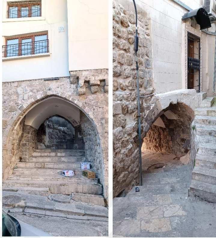
Fotoğraf 3.2 Savurkapı Mahallesi Debelen Sokakta yer alan abbara
