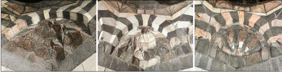
Şekil 4.16 Sultan Şüca Türbesi Tromp detayları
