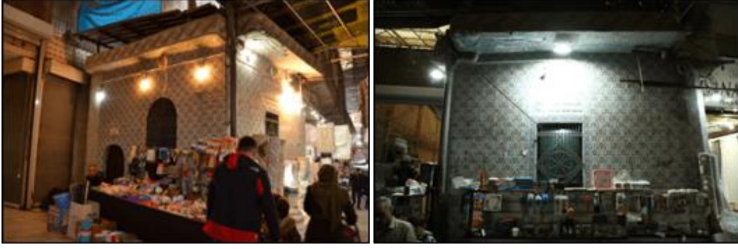
Şekil 4.128 Malik-i Ejder Türbesi Kuzey ve Batı cephe görüşleri
