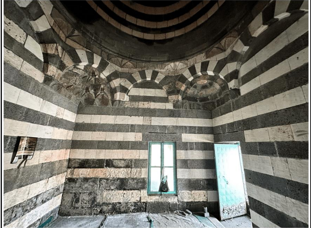
Türbe İç Batı Cephe
