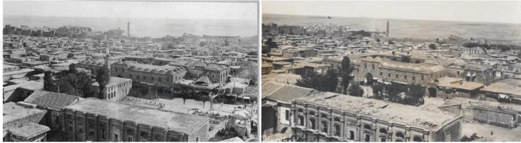
Sultan Sasa Camii yıkılmadan önceki (1925) ve sonraki durumu (VBM Arşivi)
