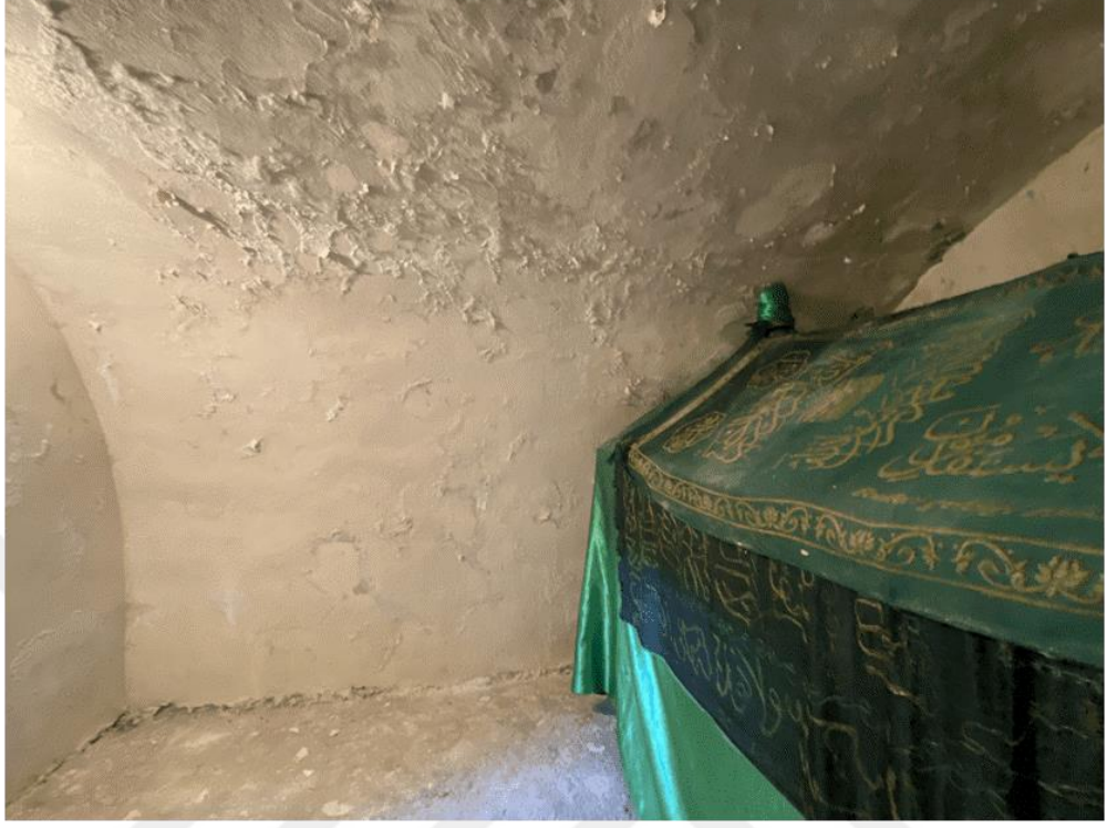
Munyalık Katı İç Görünüş
