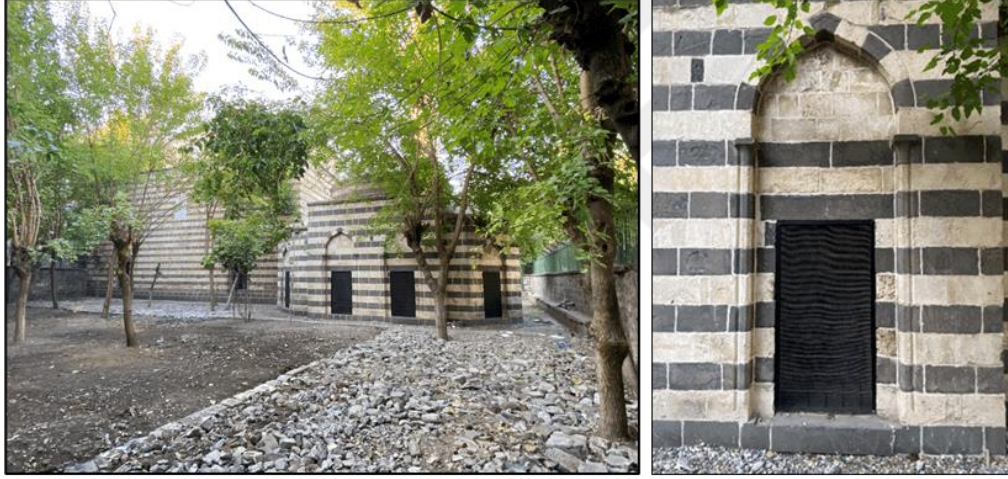
Türbenin Güney ve Güneydoğu Cephe Duvarları
