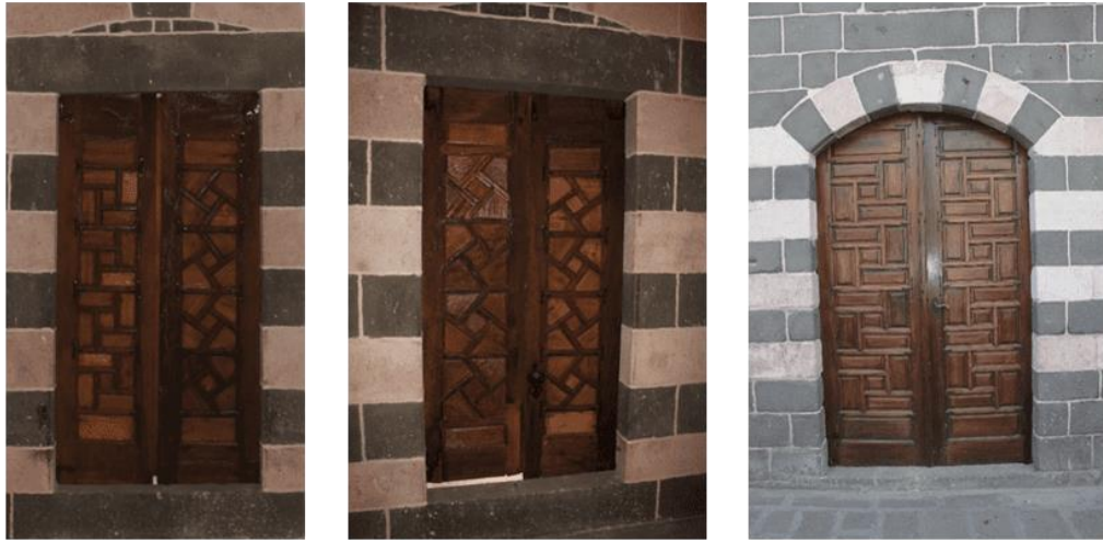
Pencere Kanatları ve Yapı Giriř Kapısı
