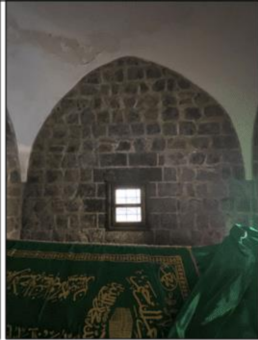
İç Kuzey Cephe
