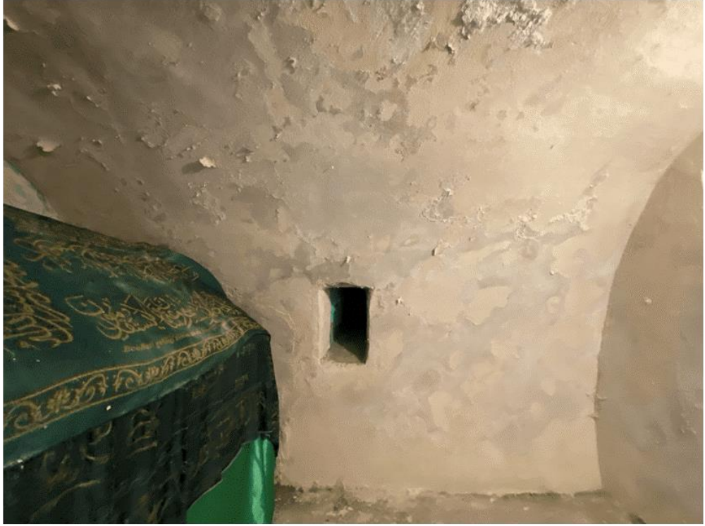
Munyalık Katı İç Görünüş
