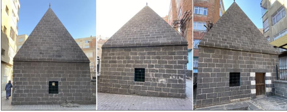
Şekil 4.20 Şeyh Yusuf Türbesi Batı, Kuzey ve Doğu cephesi
