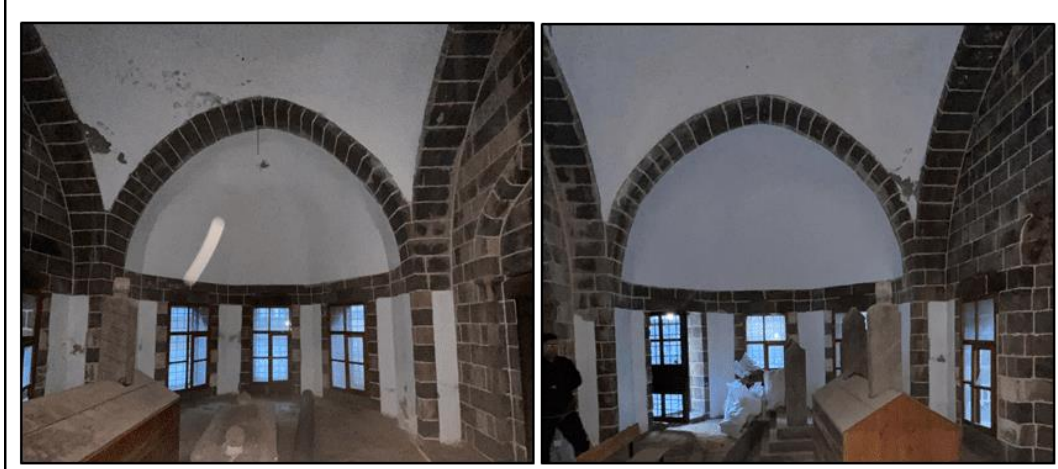
Türbe Mekânı Doğu-Batı İç Cephe
