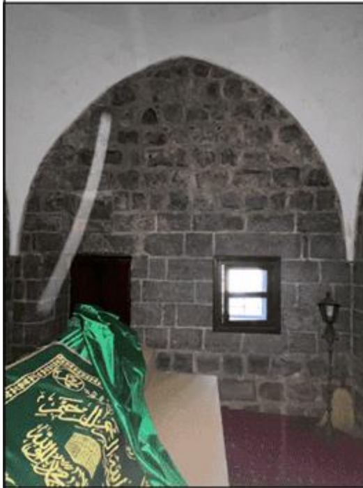
İç Doğu Cephe
