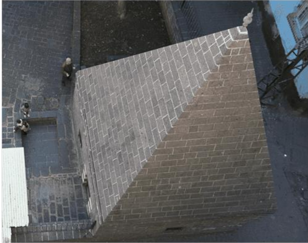
Dış Piramidal Çatı Görünüşü
