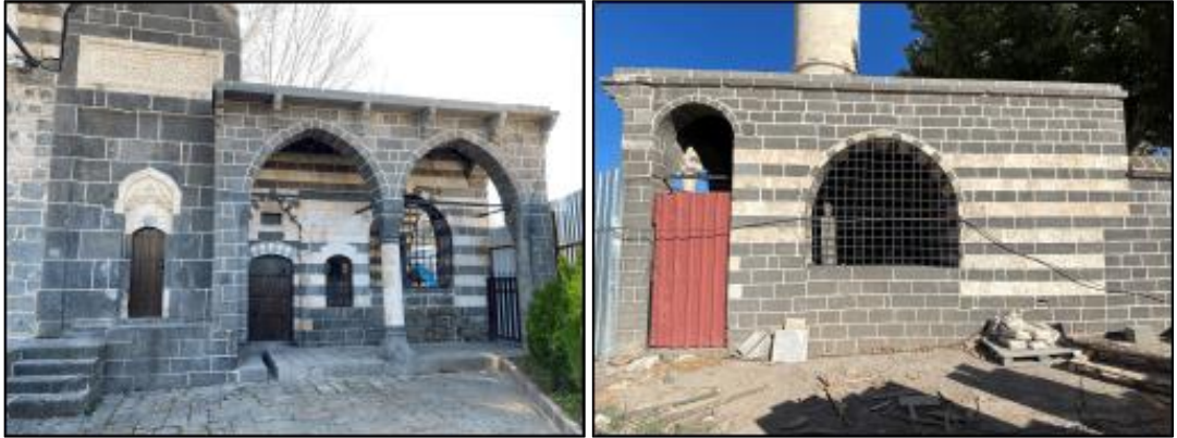
Şekil 4.123 Kurşunlu Camii Türbesi Güney ve Doğu cephesi
