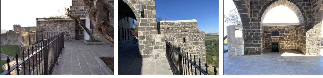
Şekil 4.9 Türbenin kuzey, güney ve batı cephe fotoğrafı
