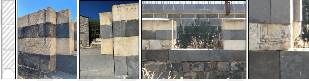
Şekil 4.38 Fatih Paşa Türbesi Güneydoğu ve Güneybatı cephe sütunce detayı, pencere silmesi
