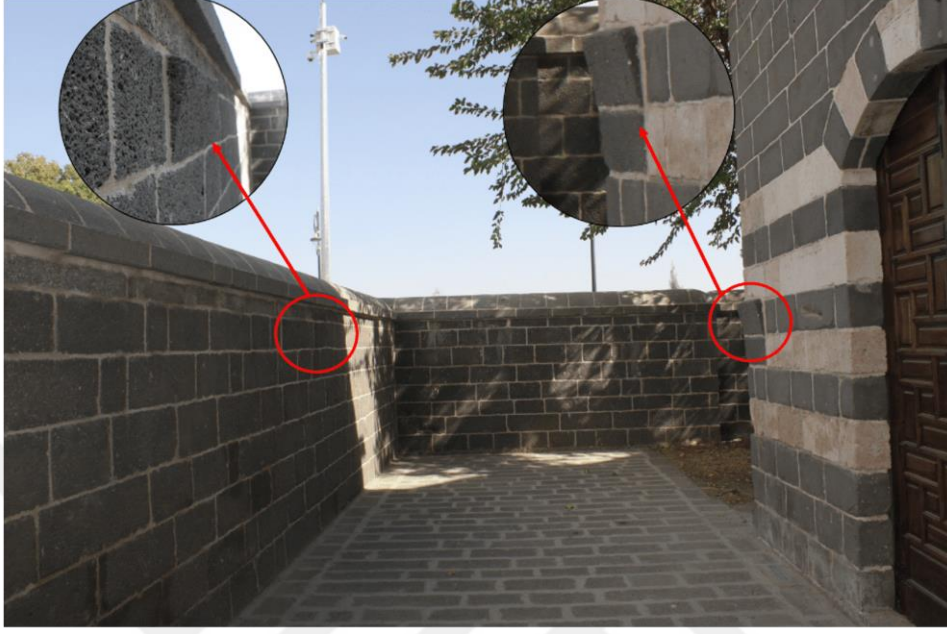
Türbe ve Avlu Duvarında Bulunan Kemer Tařı
