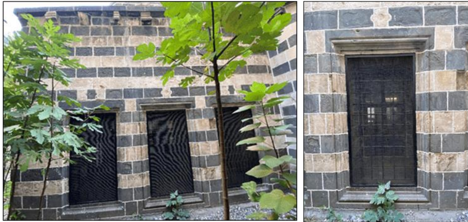
Kare Planlı Mekânın Batı Cephesi
