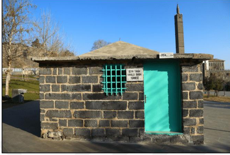
Ek 69: Havlet Baba Türbesi Cephe Fotoğrafları (Güney, Doğu ve Batı Cephesi)
