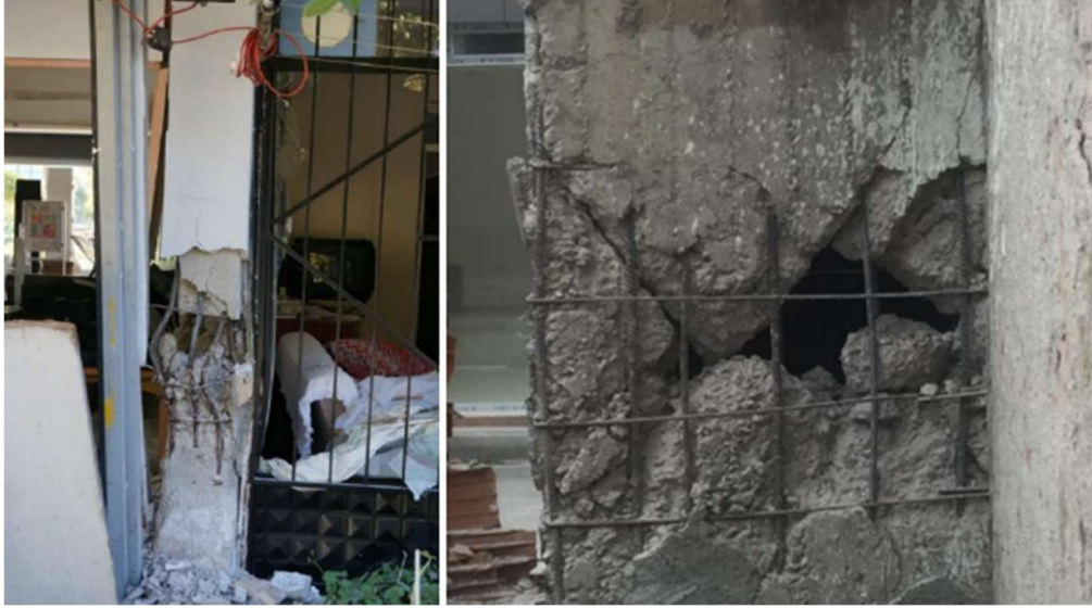
Şekil 1.8. Yetersiz Etriyeleme [3]
