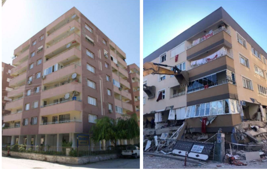
Şekil 1.5. Yumuşak Kat Kaynaklı Hasar[1]
