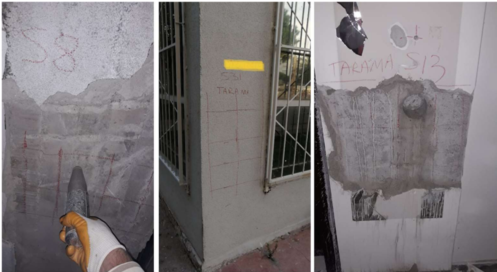
Şekil 4.19. Donatı Tespit Çalışmaları 4
