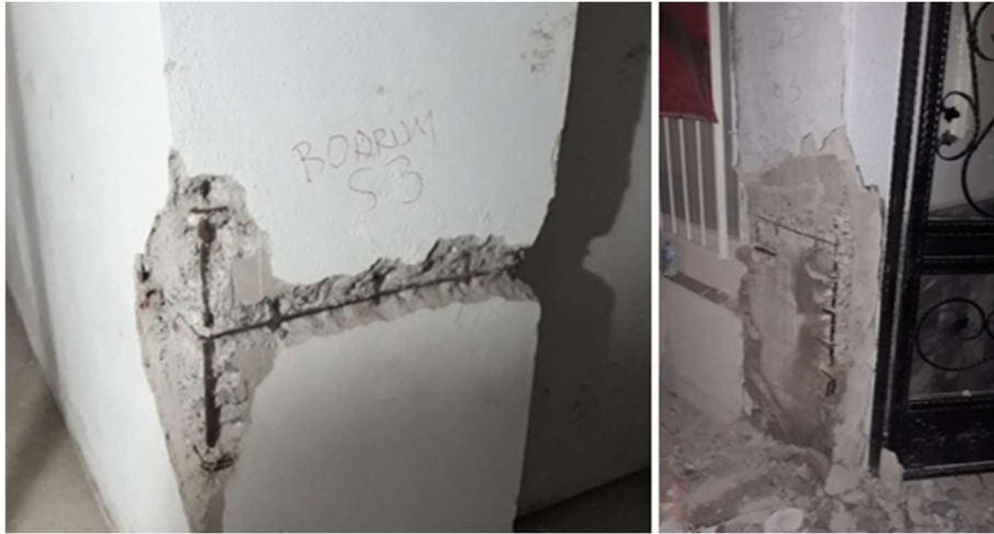
Şekil 4.16. Donatı Tespit Çalışmaları 1
