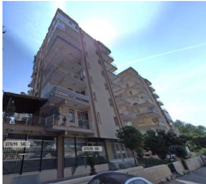
Şekil 4.1. İncelenen Yapı A Blok Yan Cepheden Görünümü
