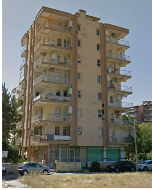
Şekil 4.2. İncelenen Yapı B Blok Ön Cepheden Görünümü
