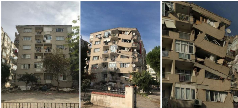
Şekil 1.4. Yetersiz Malzeme ve Köşe Kolon Hasarı [3]
