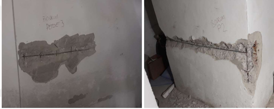
Şekil 4.18. Donatı Tespit Çalışmaları 3
