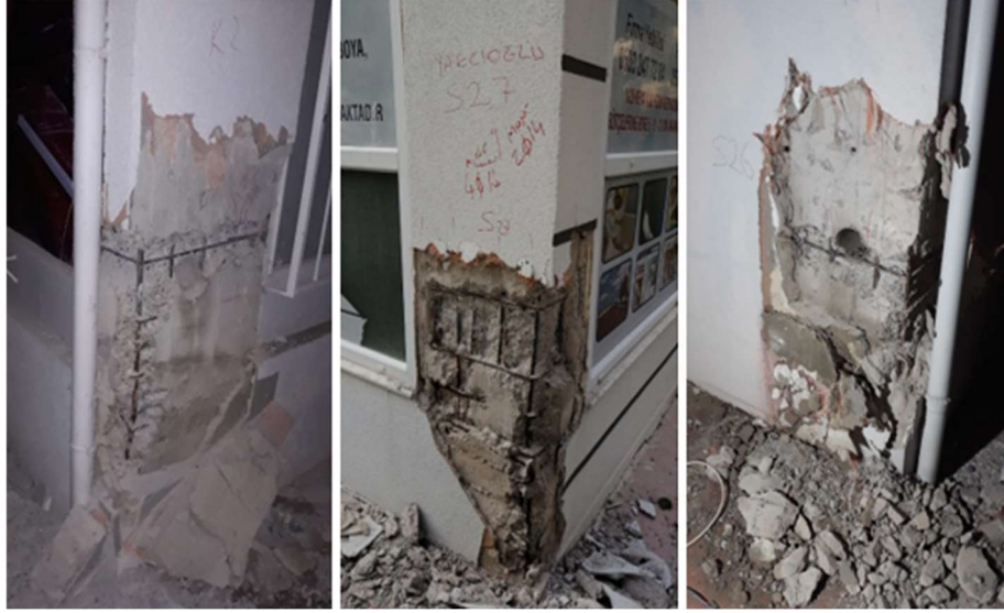
Şekil 4.17. Donatı Tespit Çalışmaları 2
