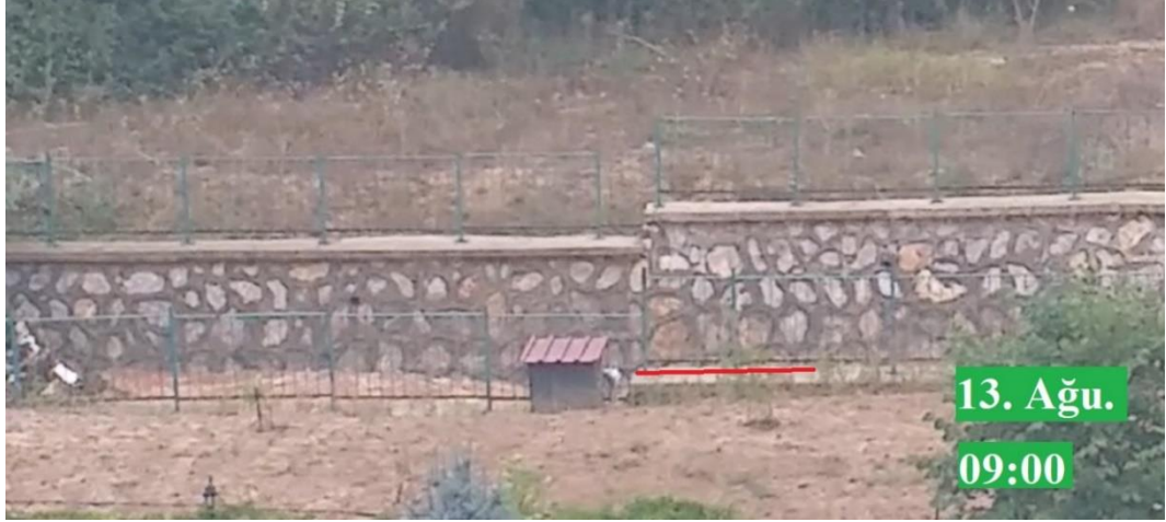
Şekil 4.22. Sağanağın başlangıcından 60 saat sonra kesitte gözlenmiş su seviyesi
